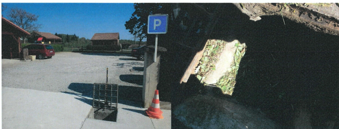
Regard EP n°2024 – Passage Ø400 à Ø300
