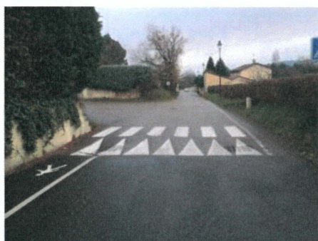
Exemple de grilles positionnées en amont d'un ralentisseur
