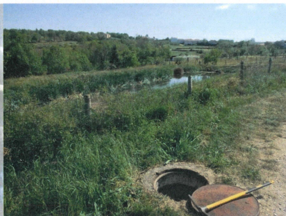
DO 1 – Entrée STEP de Gencenas – Vue extérieure
