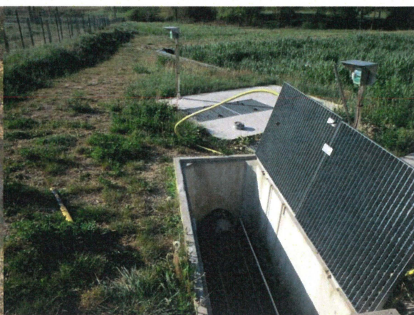
DO 4 – Entrée STEP du Bourg – Vue extérieure
