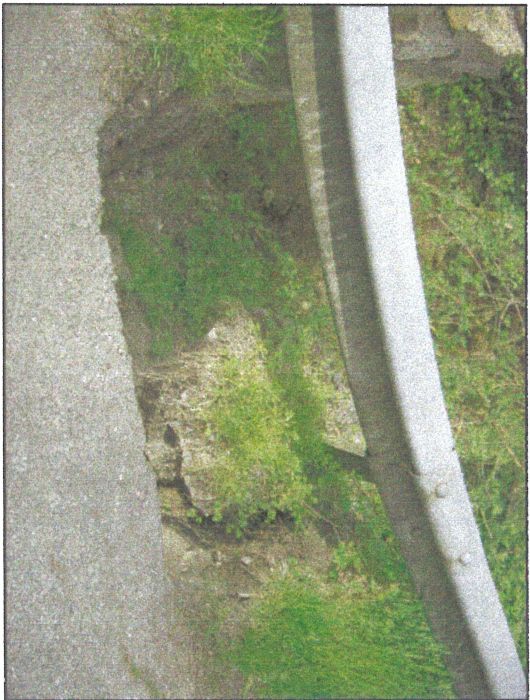
Photo 2: Effondrement de la chaussée du CR de la Grivaz
