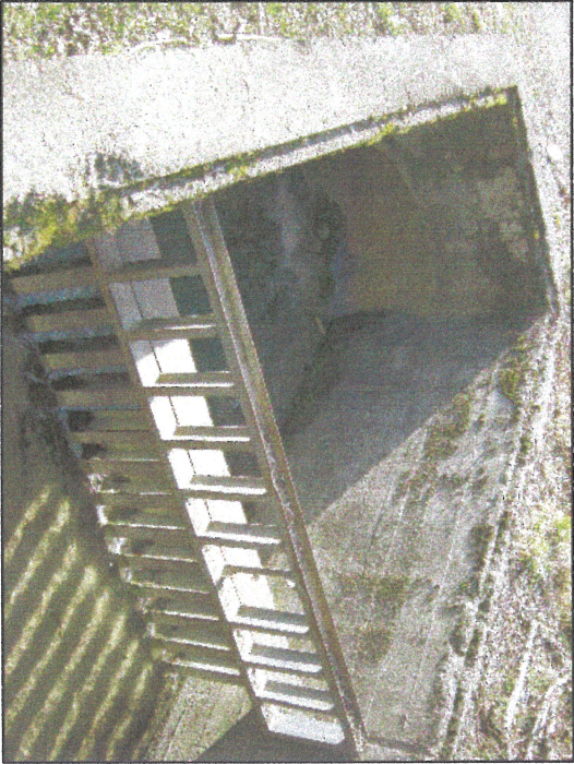
Photo 1: Ouvrage d'entonnement au noeud M10
