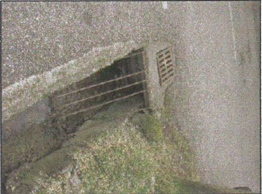
Photo 2: Entonnement des eaux de ruissellement du fossé au point P40
