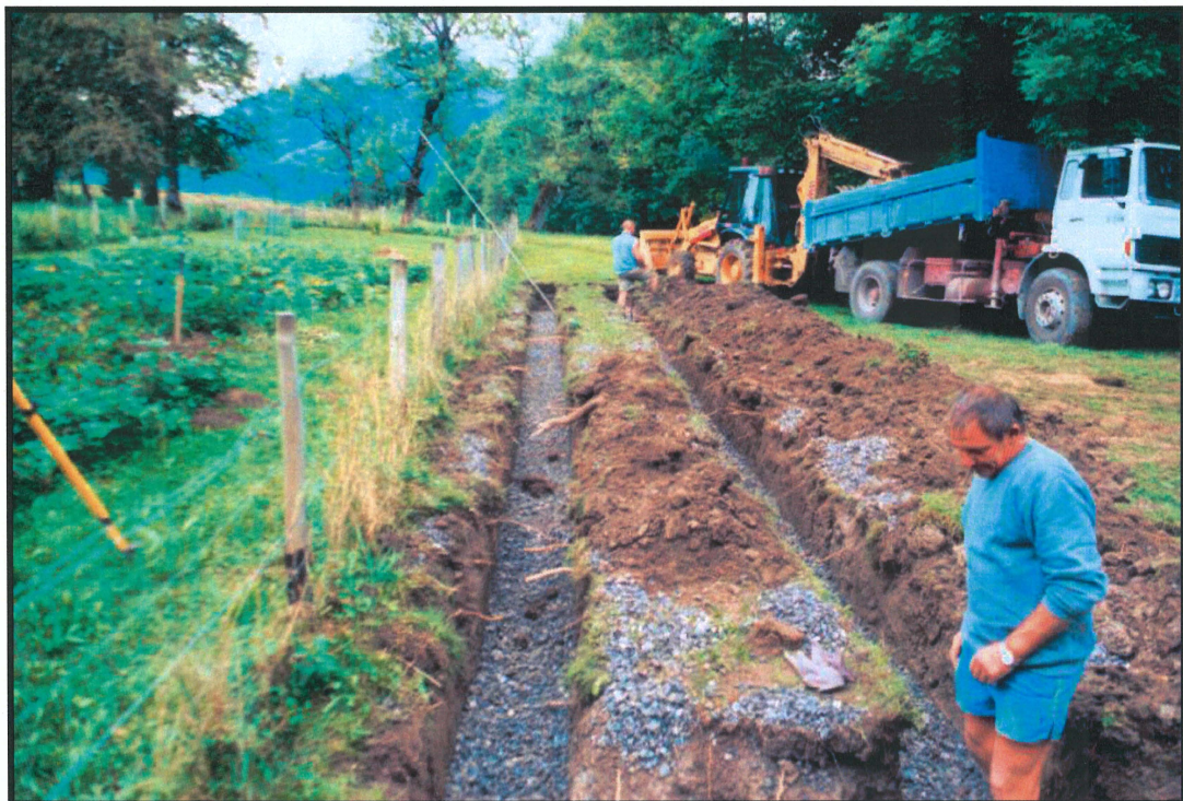
Tranchées d'épandage en cours de réalisation
