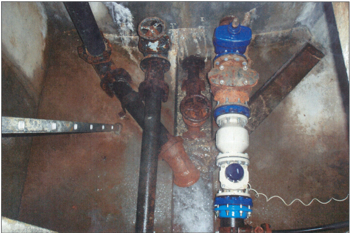
Compteur de distribution 1 – Vidange et trop plein – Distribution 2
