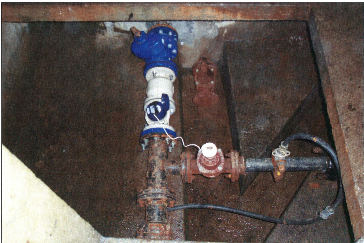
Compteur de distribution et bypass adduction/distribution
