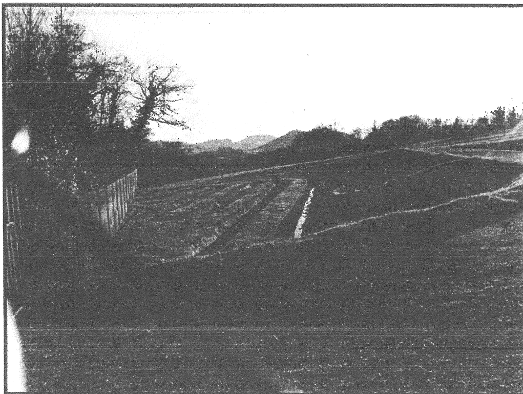
Le fossé de dissipation en fin de traitement après les étages de lits à macrophytes
