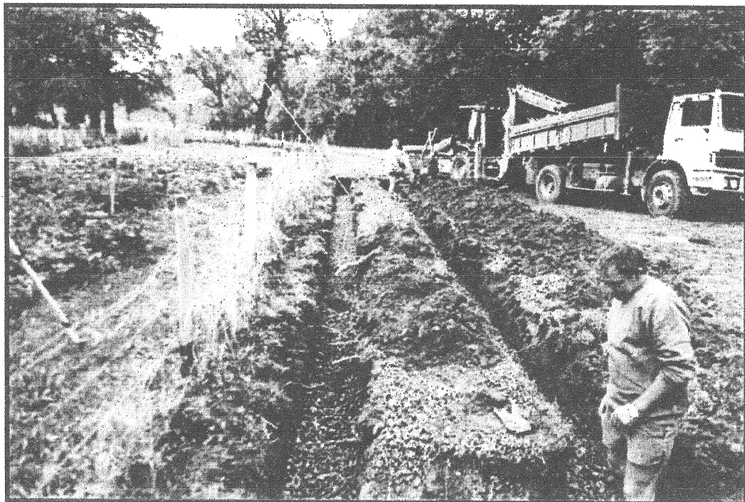
Tranchées d'épandage en cours de réalisation
