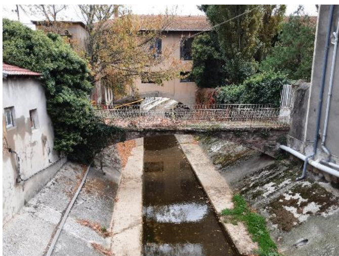
Illustration 83 : Artificialisation des berges de l'Écoutay dans la traversée de Beaumont-lès-Valence – ECOU_3C
