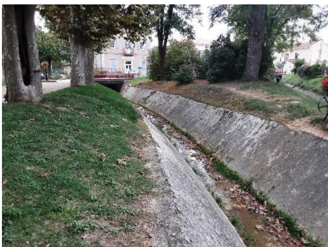
Illustration 82 : Artificialisation des berges du ruisseau de Bost dans la traversée de Montvendre – RBOS_1B
