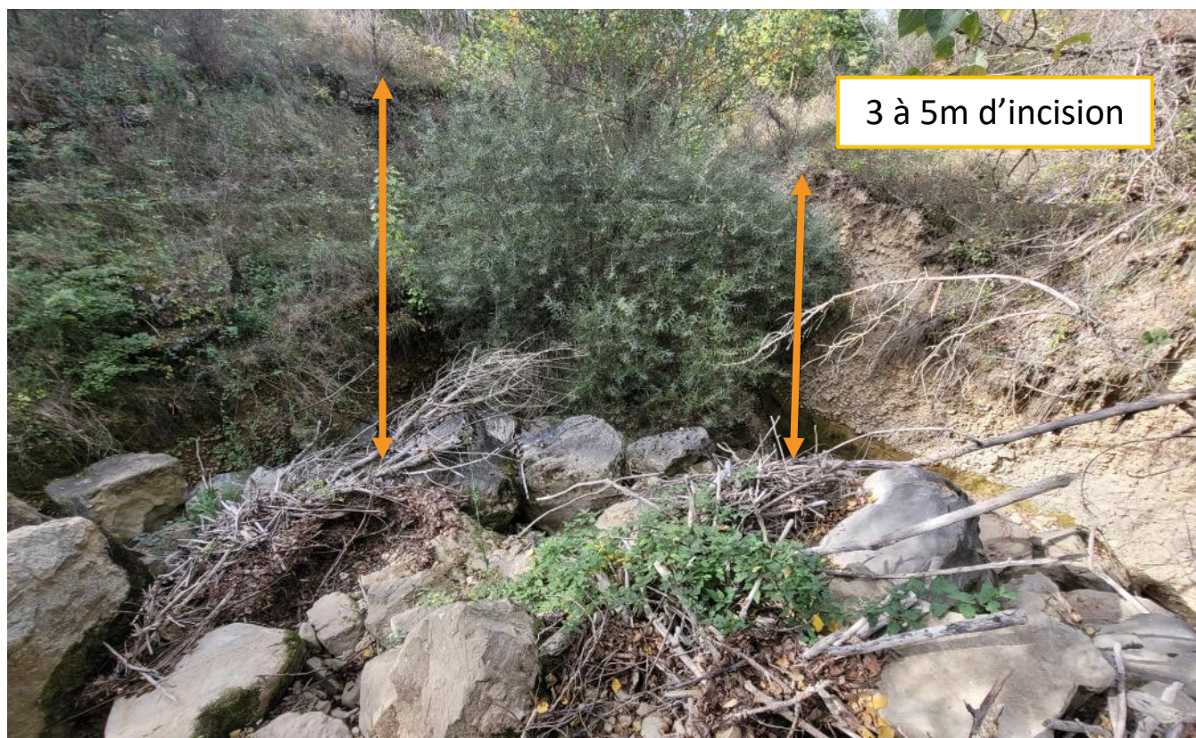
Illustration 78 : Incision de près de 3 à 5m de la Barberolle dans son lit alluvial en aval du bassin écrêteur de crue de Bésayes – BARB_3B
