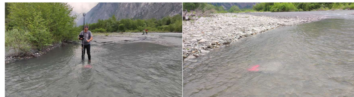
Figure 89 - Installation des plaques d'impacts le 24/05/2023.
