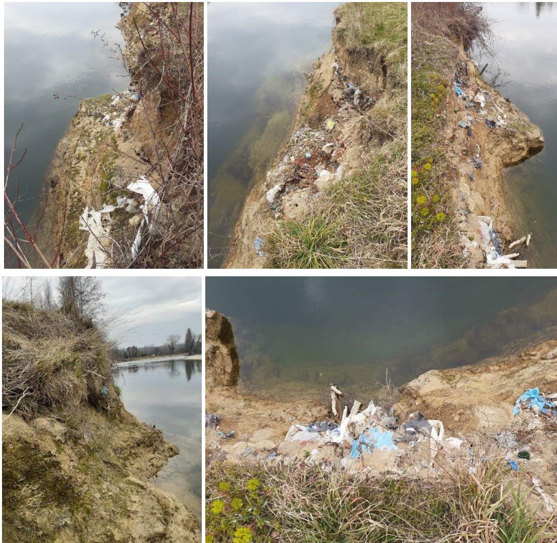
Figure 8 : Erosions de berges en partie Sud du site
