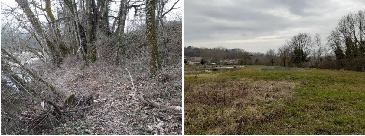
Figure 10 : Vue générale de la limite Sud du site (gauche) et de la STEP (droite)
