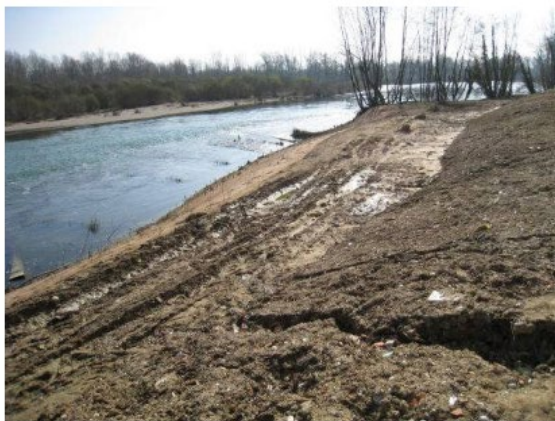
Vue depuis la décharge fille vers la rivière d'Ain (décharge mère en pied de talus)
