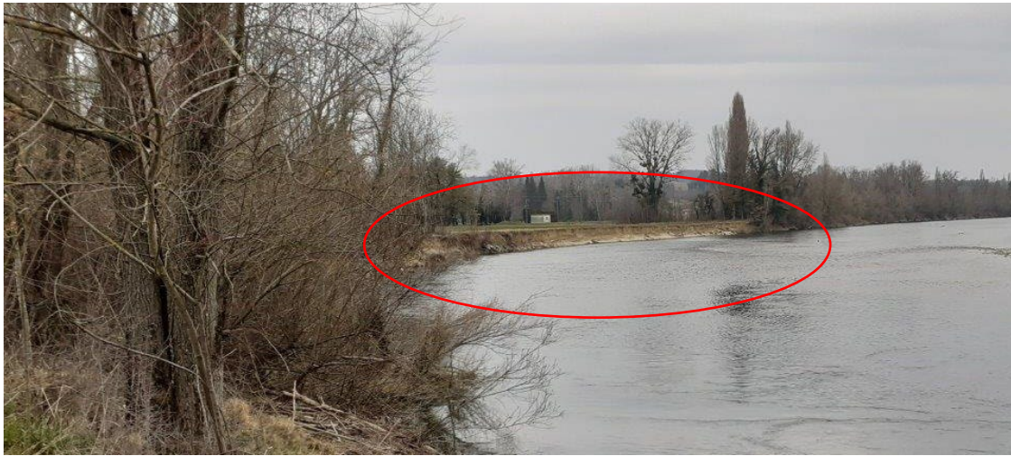
Figure 6 : Erosions de berges le long des champs 100 m en amont du site
