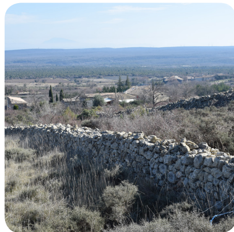
Réseau de murets en pierre sèche
