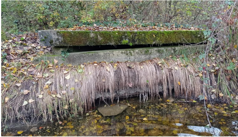
Figure 85 : Massif béton au droit de l'ouvrage OH2
