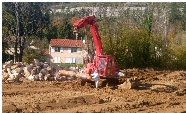
Figure 84 : Chantier de dépose de conduites amiantifères (MOE SAGE Environnement – 2019)
