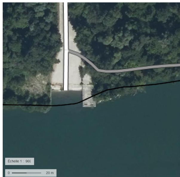
Figure 76 : Point de rejet aval
