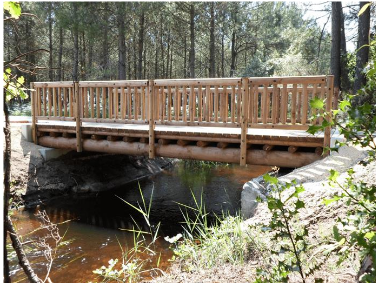
Figure 83 : Exemple de passerelle véhicule léger
