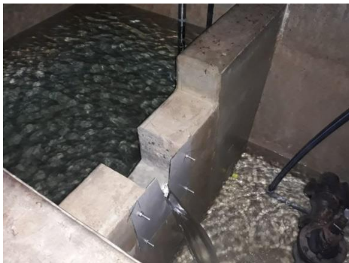
Exemple de mesure de débit sur un captage avant trop plein
