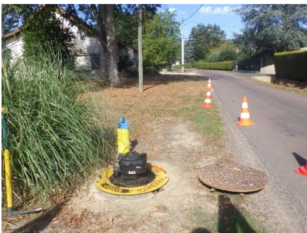
1 - Injection de fumée dans le réseau d'eaux usées
