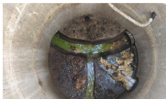
3 - Validation de la connexion hydraulique à l'aide de colorant
