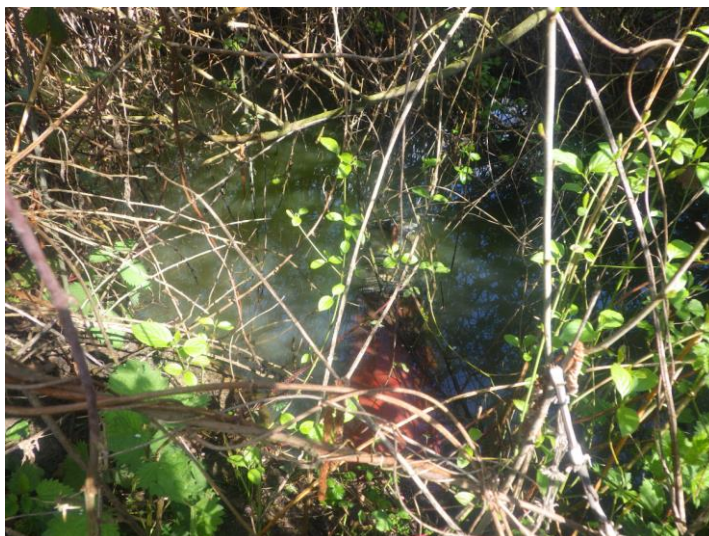
Exutoire de la station sous l'eau après les pluies de mars
