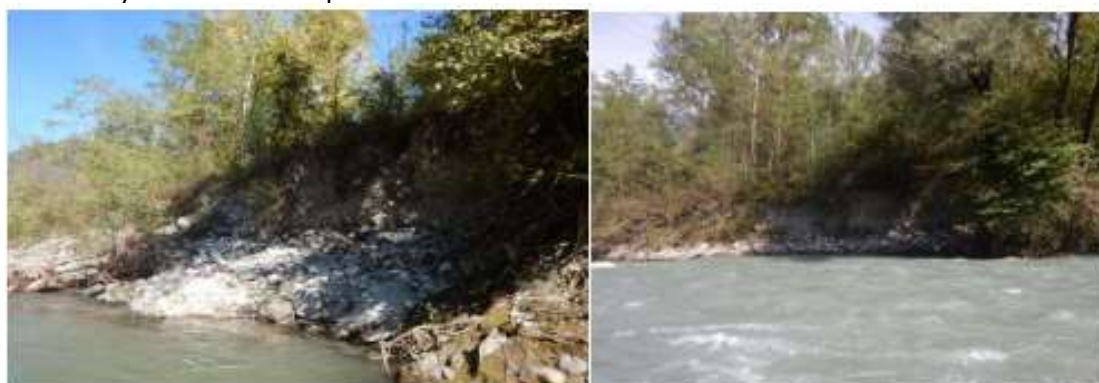
Figure 120 : Erosion active en 2018 et 2021 en rive gauche à l'amont du site des Vernays
