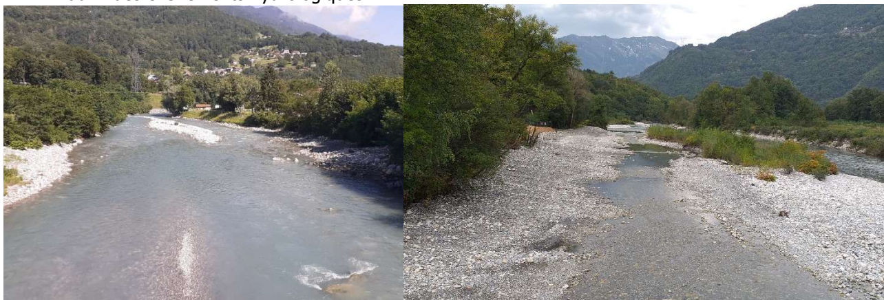
Figure 32 : Photographies après travaux sur le site de Cevins à gauche et de St Thomas à droite
