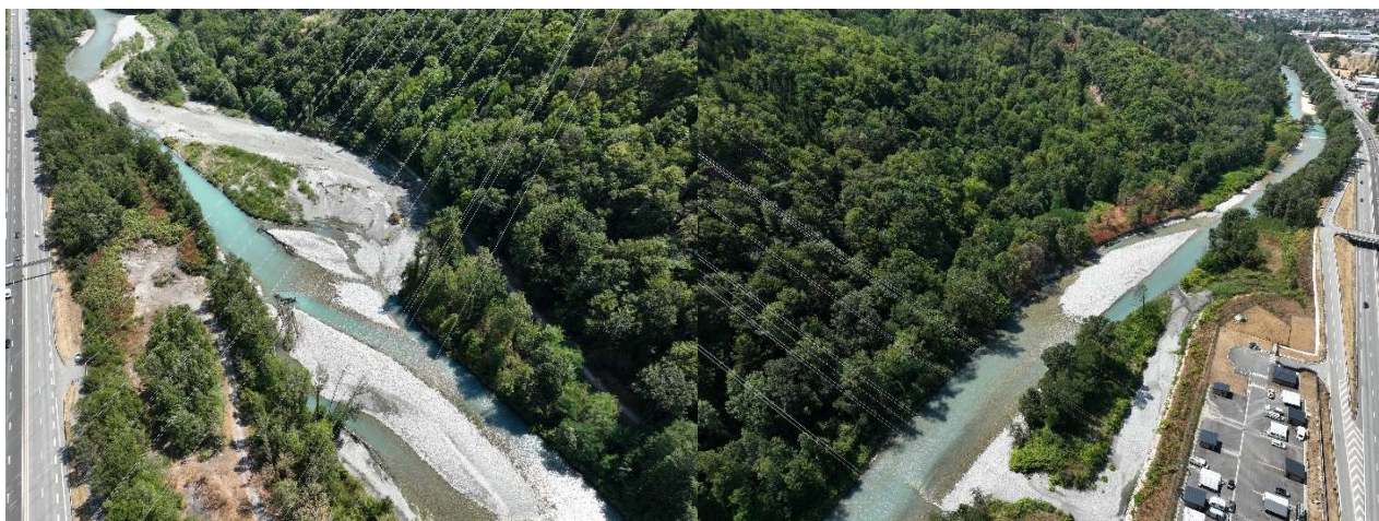
Figure 126 : Erosions en rive gauche au droit du poste électrique (Aout 2022)
