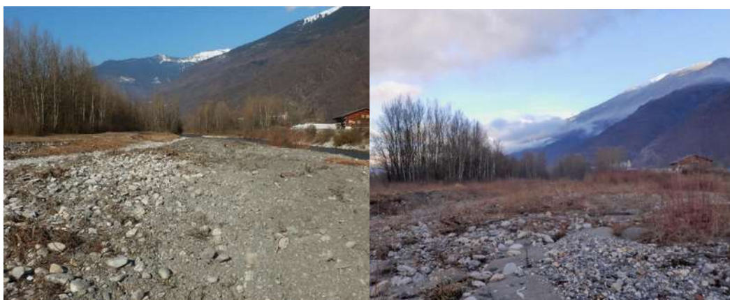
Figure 111 : Banc après travaux (février 2019 en bas à gauche) et après quatre saisons végétatives (février 2022 en bas à droite)
