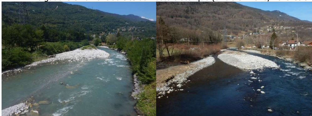
Figure 28 : Travaux de réouverture des bras de Cevins (2018 à gauche et 2019 à droite)
