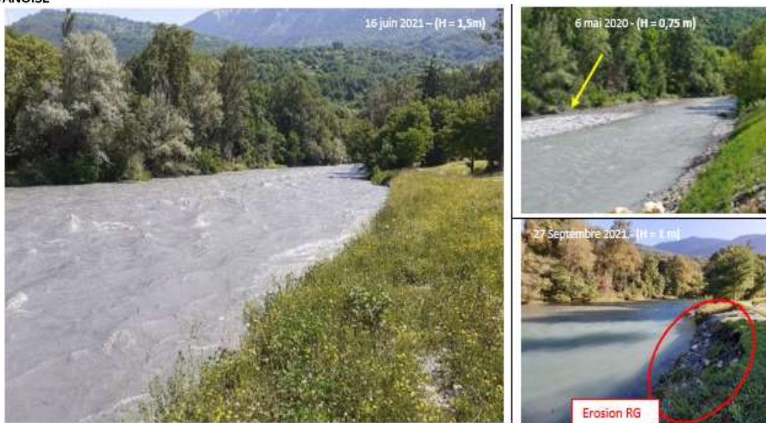
Figure 130 : Erosion de berge rive gauche lors de la chasse 2021 à la confluence Morel – Isère (APTV, 2021)
