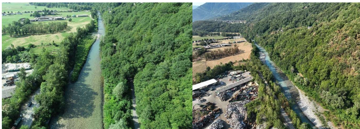
Figure 158 : Vue amont du banc arasé aux Vernays avant et après travaux (juillet 2020 et aout 2022)
