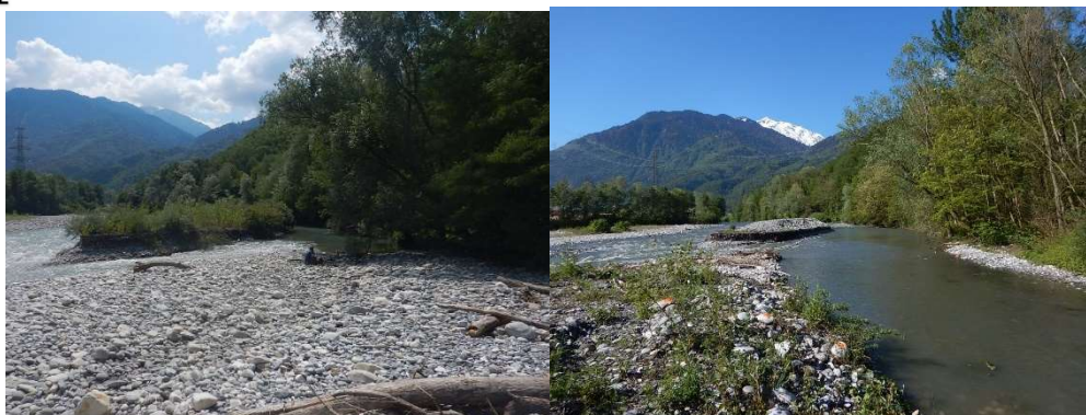
Figure 31 : Modification du profil du banc amont (en 2018 à gauche avant travaux et en 2019 à droite après travaux)
