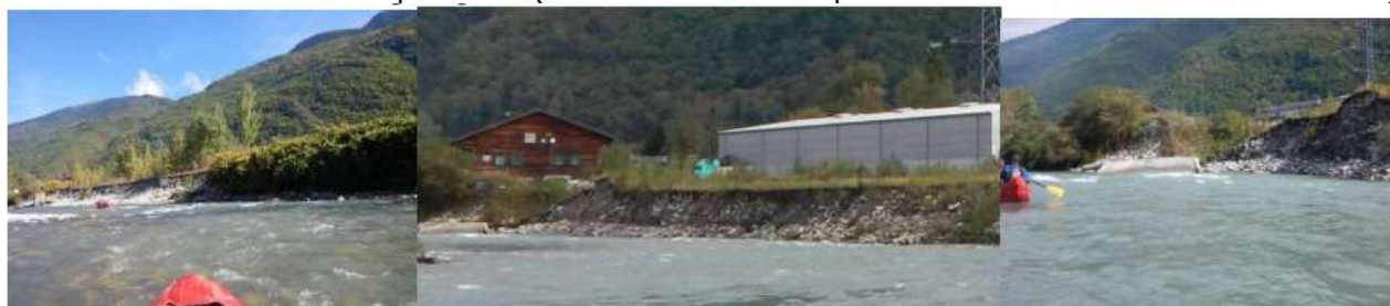
Figure 115 : Erosion de berge rive droite au droit de la zone des Arolles
