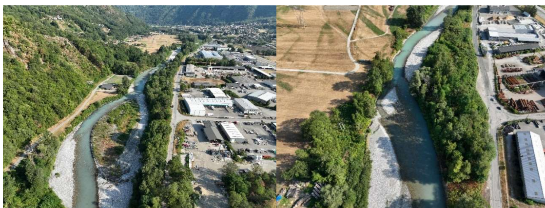
Figure 119 : Erosions en rive gauche et en rive droite au droit de la zone des Vernays (Aout 2022)
