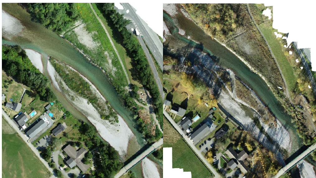
Figure 33 : Ortho photos avant et après travaux sur le site de St Thomas
