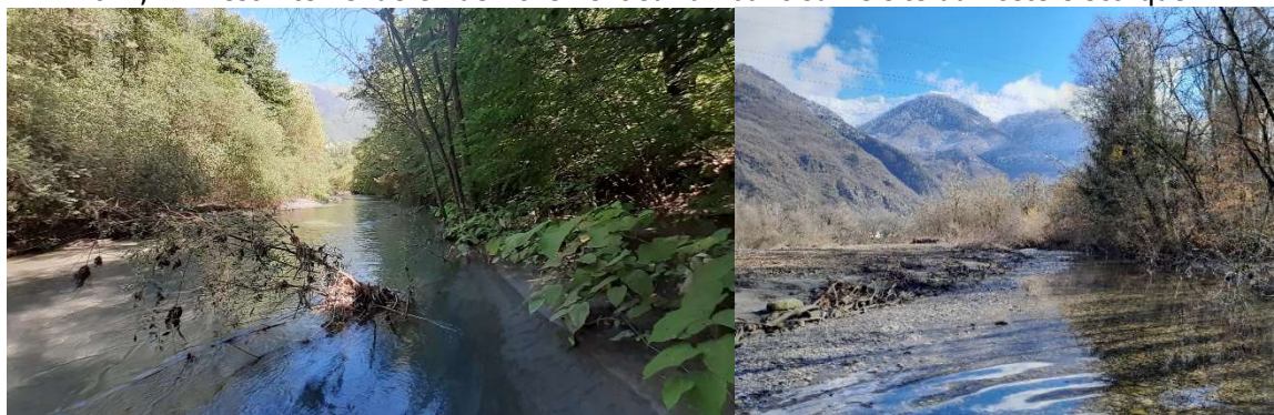
Figure 34 : Défrichage par RTE d'un banc en 2021 sur le site du Poste électrique (à gauche avant en 2020 et à droite après travaux en 2021)
