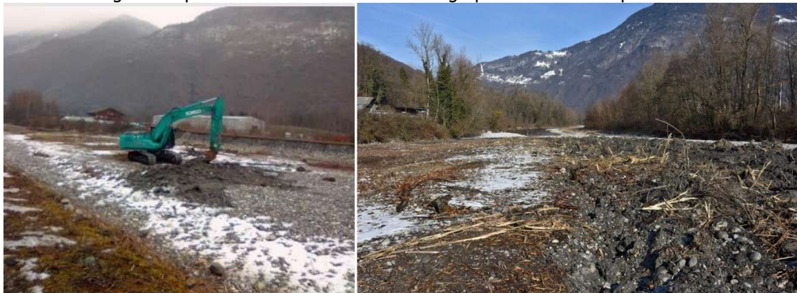
Figure 29 : Bande essartée non scarifiée (à gauche) et essartée scarifiée (à droite) - Banc des Vernays (INRAE, 2020)
