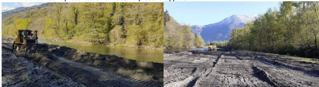
Figure 30 : Travaux d'arasement du banc aux Vernays (en bas)
