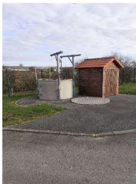
Figure 31 : Photos de la station d'épuration
