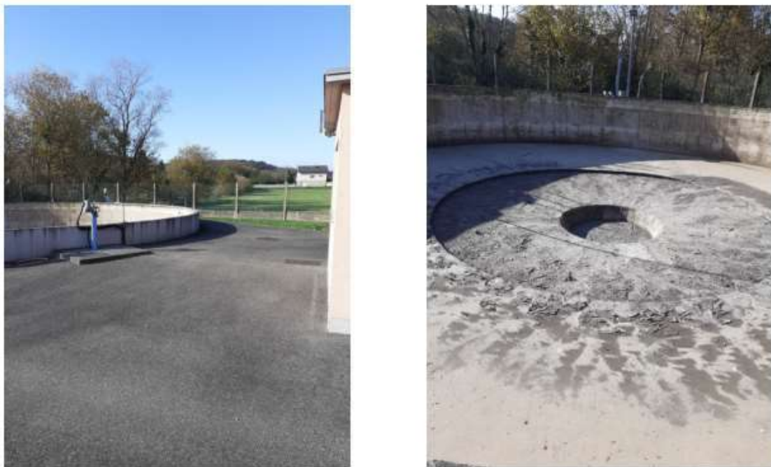
Figure 22 : Photographies du bassin d'orage de Pérouse
