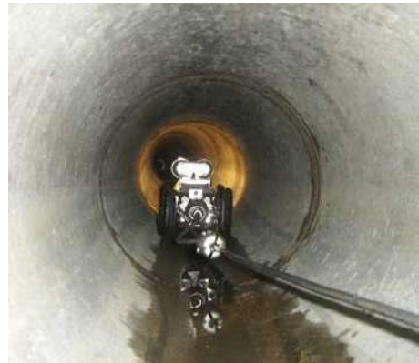
Principe de déroulement d'une inspection télévisée
