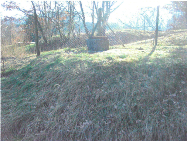
Ouvrage de captage
