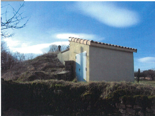
Vue extérieure réservoir et local de traitement
