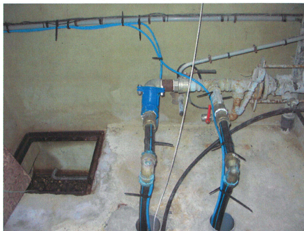
Chambre de vannes située au dessus du bassin
