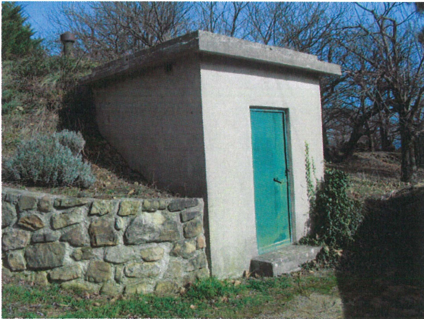
Vue extérieure réservoir
