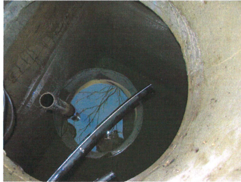
Vue par la trappe de visite
