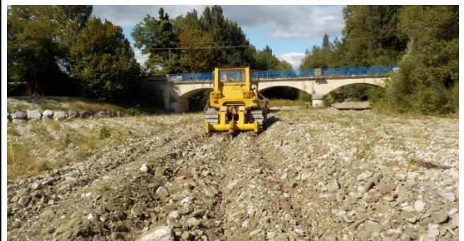
Exemple de scarification d'atterrissement
