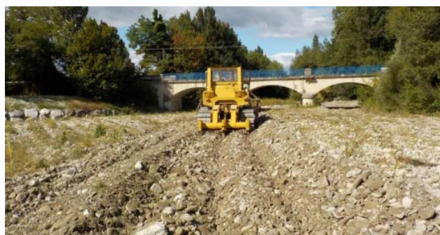
Exemple de scarification d'atterrissement
