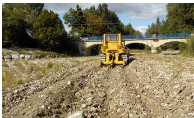
Exemple de scarification d'atterrissement
