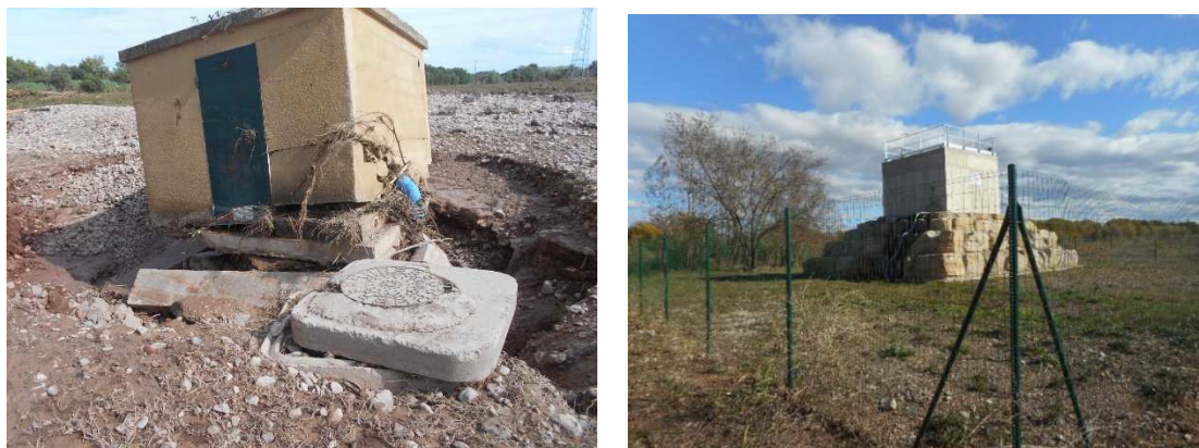
Captage du Mas de Marre en 2015 après les crues à gauche et en 2017 à droite
