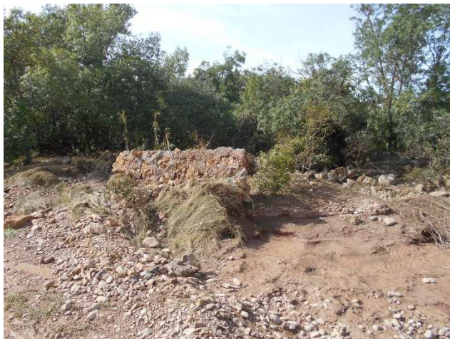
Brèches créées sur le tronçon existant suite au crues de 2015 (photo post-crue 2015)
