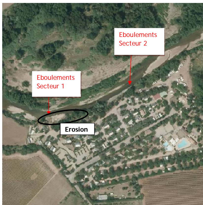
Localisation des éboulements observés sur la falaise du camping
