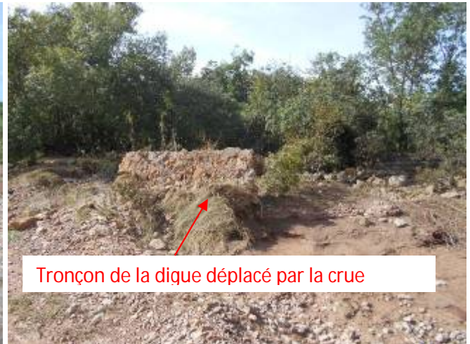
Nouvelle brèche (à gauche) et ancienne quatrième brèche (à droite) - crue du 12-13/09/2015
