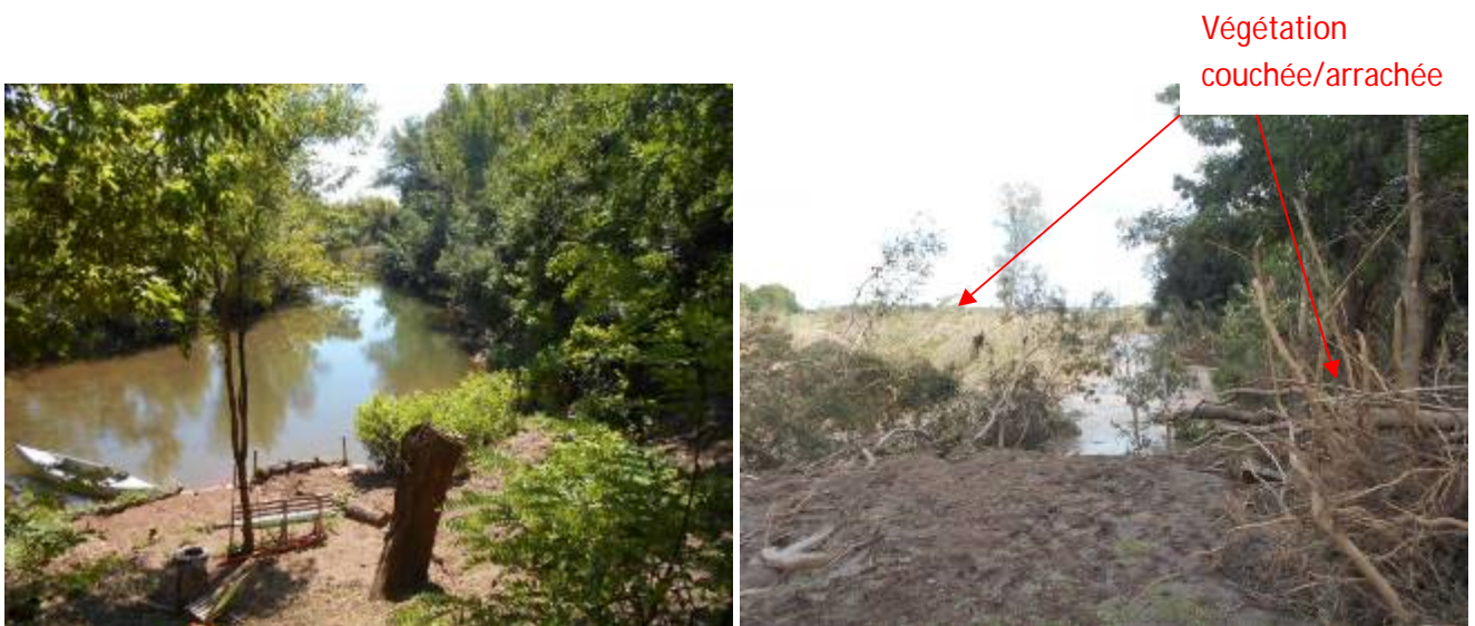
Mas Tournal - Vue des berges aménagées avant et après la crue du 12-13/09/2015 respectivement à gauche et à droite
