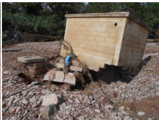
Mas de Marre - Troisième brèche au droit du captage et captage du Mas de Marre - crue du 12-13/09/2015
