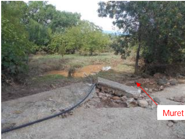
Destruction du muret protégeant l'habitation du Mas de Marre à droite - crue du 12-13/09/2015
