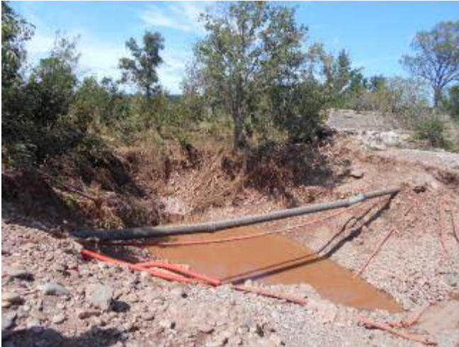
Mas de Marre - Première et seconde brèches respectivement à gauche et à droite - crue du 23/08/2015
