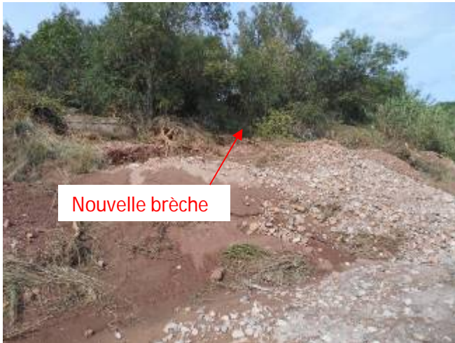
Nouvelle brèche (à gauche) et ancienne quatrième brèche (à droite) - crue du 12-13/09/2015
