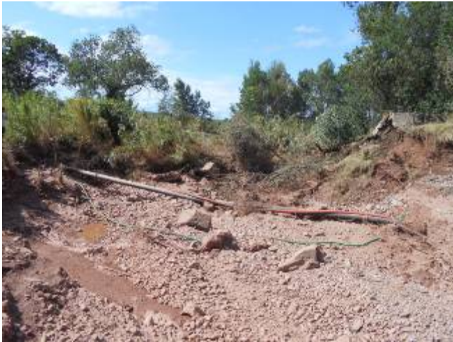
Mas de Marre - Troisième brèche au droit du captage et captage du Mas de Marre - post-crue du 23/08/2015
