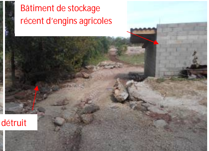
Destruction du muret protégeant l'habitation du Mas de Marre à droite - crue du 12-13/09/2015
