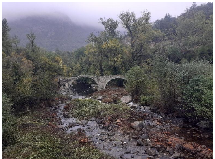
Photographies avant et après travaux
