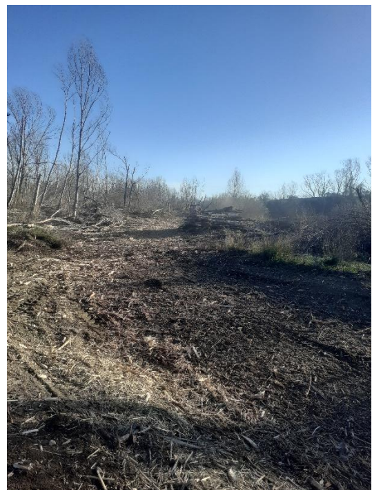
Photographies avant et après travaux
