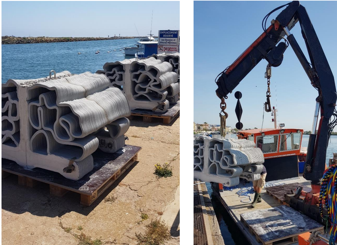
Figure 49 : chargement des récifs sur la barge
