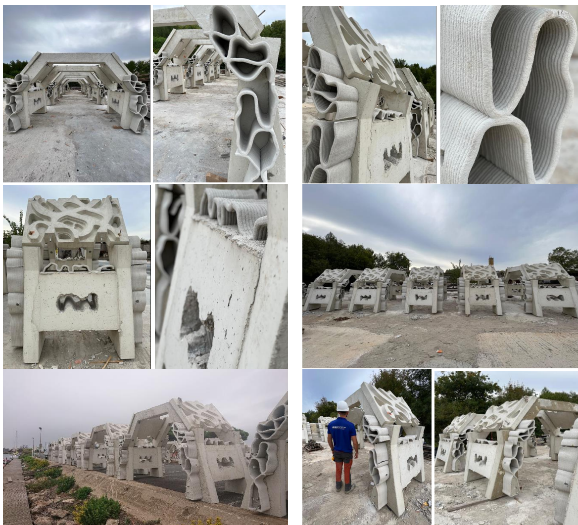
Figure 20 : Modules 3D'Complex après assemblage. L'ensemble des opérations ont été réalisées en Occitanie
