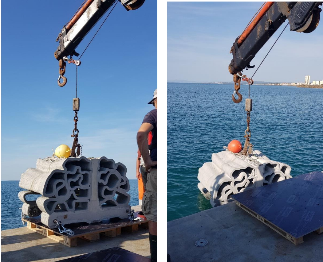
Figure 50 : Immersion des récifs
