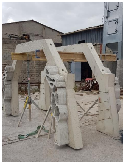
Figure 19 : Mise en place des arches pour réalisation de la liaison du module 3D'Complex. L'ensemble des opérations ont été réalisées en Occitanie.
