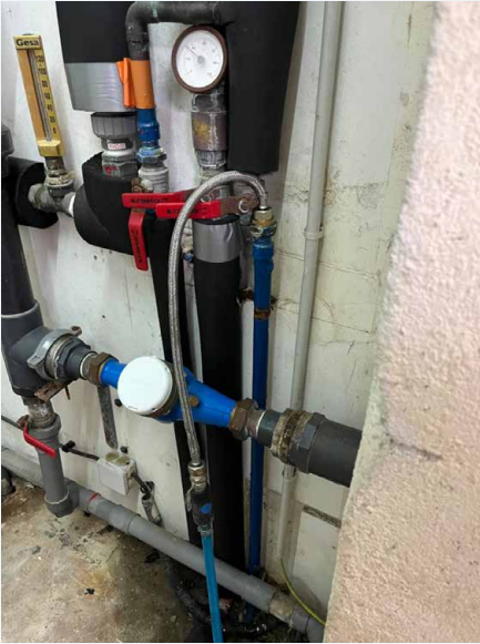
Branchement de l'azote hydrogénée sur la conduite aep
