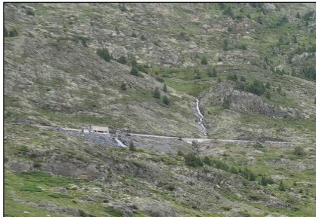
8. Barrage EDF sur le Rec du Cortal Rosso à Porté- Puymorens
