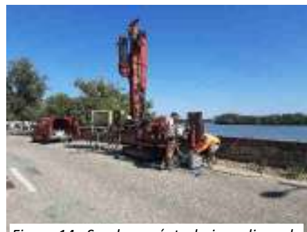
Figure 14 : Sondage géotechnique digue de Saint Etienne des Sorts
