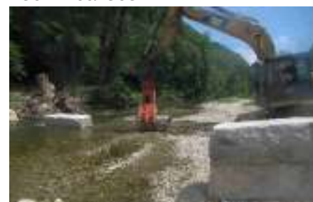
Figure 14 : Pose de blocs à Meyrannes-Molières Juillet 2024
