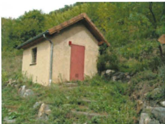
Local Station de pompage et UV de Savel
