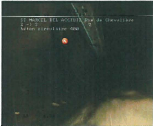
Photo: 0000015.JPG, 00:00:03 1,99m, Écoulement dans canalisation entrante, clair, aucun mauvais raccordement observé à 11 h., -
