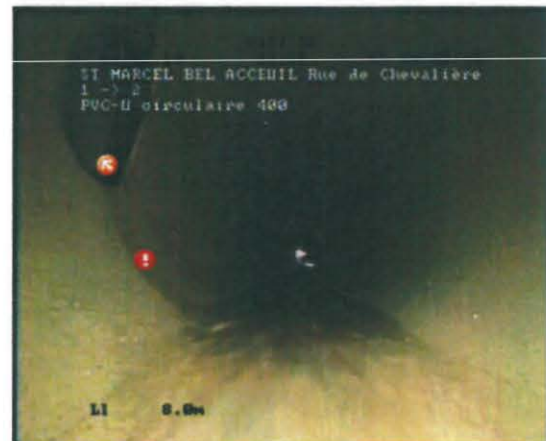
Photo: 0000006.JPG, 00:02:23 8,29m, Écoulement dans canalisation entrante, clair, aucun mauvais raccordement observé à 10 h., -
