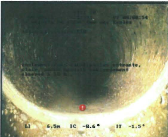
Photo: 0000017.JPG, 00:00:52 6,56m, Écoulement dans canalisation entrante, clair, aucun mauvais raccordement observé à 10 h., -
