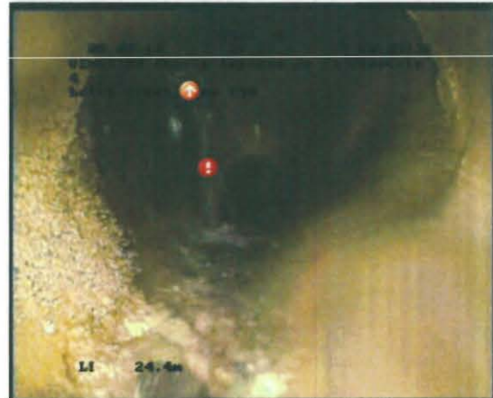
Photo: 0000043.JPG, 00:03:07 25,04m, Écoulement dans canalisation entrante, clair, aucun mauvais raccordement observé à 11 h., -
