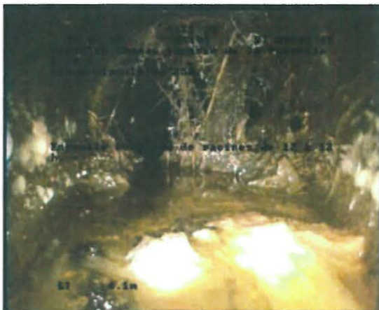
Photo: 0000003.JPG, 00:01:14 6,27m, Ensemble complexe de racines de 12 à 12 h. -, joint
