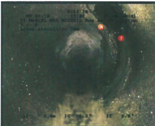
Photo: 0000041.JPG, 00:00:29 5,68m, Écoulement dans canalisation entrante, clair, aucun mauvais raccordement observé à 1 h., -
