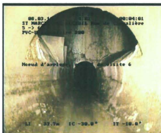
Photo: 0000030.JPG, 00:04:01 38,38m, Noeud d'arrivée, regard de visite 6
