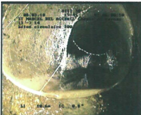
Photo: 0000075.JPG, 00:00:41 10,6m, Piquage direct, buriné, raccordement ouvert à 3 h., -, (-)
