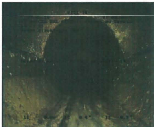
Photo: 0000078.JPG, 00:00:00 0m, Noeud de départ, regard de visite 14
