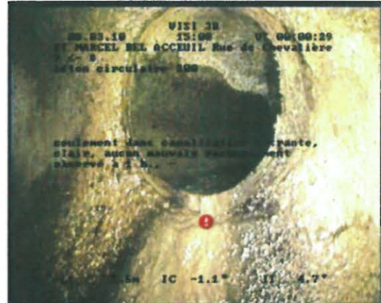
Photo: 0000040.JPG, 00:00:29 5,68m, Écoulement dans canalisation entrante, clair, aucun mauvais raccordement observé à 1 h., -
