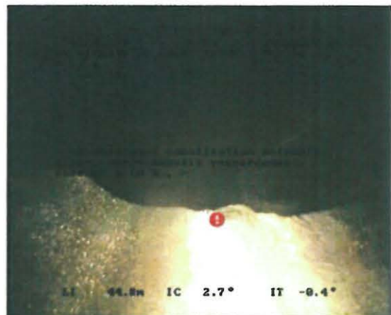
Photo: 0000026.JPG, 00:04:57 44,84m, Écoulement dans canalisation entrante, clair, aucun mauvais raccordement observé à 10 h., -
