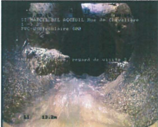
Photo: 0000009.JPG, 00:04:03 13,88m, Noeud d'arrivée, regard de visite 2
