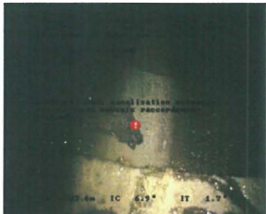
Photo: 0000033.JPG, 00:02:35 25,68m, Écoulement dans canalisation entrante, clair, aucun mauvais raccordement observé -, -
