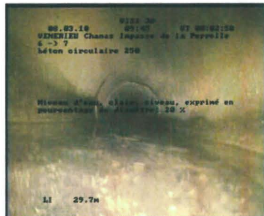
Photo: 0000051.JPG, 00:02:50 29,73m, Niveau d'eau, clair, niveau, exprimé en pourcentage du diamètre: 20 %
