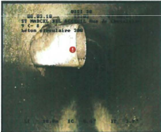
Photo: 0000043.JPG, 00:01:47 19,02m, Branchement pénétrant -, saillie longueur de la saillie: 50 % du diamètre
