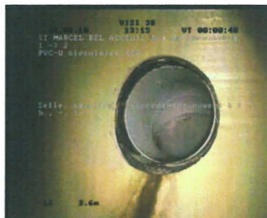
Photo: 0000002.JPG, 00:00:40 3,66m, Selle, carottée, raccordement ouvert à 1 h., -, (-)
