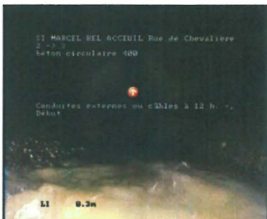
Photo: 0000011.JPG, 00:00:08 0,37m, Conduites externes ou câbles à 12 h. -, Début
