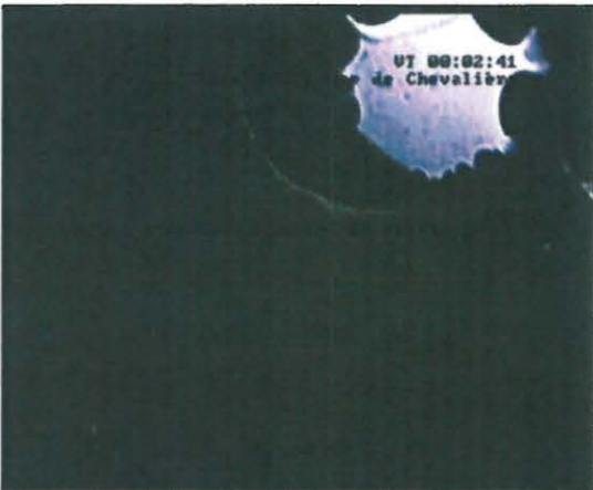
Photo: 0000050.JPG, 00:02:41 34,25m, Noeud d'arrivée, regard de visite 10
