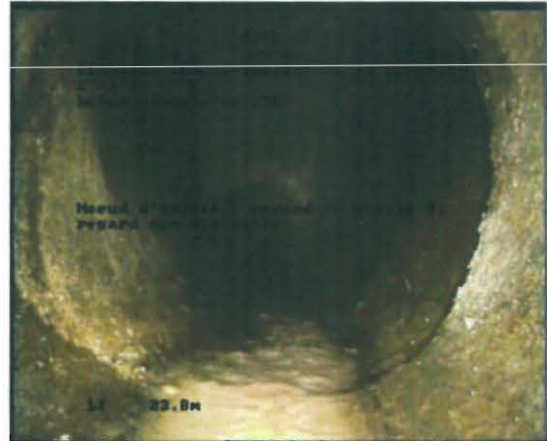
Photo: 0000020.JPG, 00:03:13 24,43m, Noeud d'arrivée, regard de visite 3
