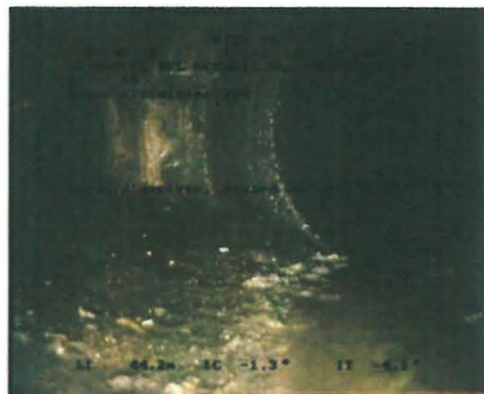
Photo: 0000093.JPG, 00:04:19 44,27m, Noeud d'arrivée, regard de visite 19
