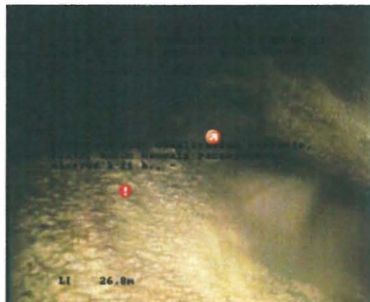
Photo: 0000037.JPG, 00:07:10 26,86m, Écoulement dans canalisation entrante, clair, aucun mauvais raccordement observé à 11 h., -
