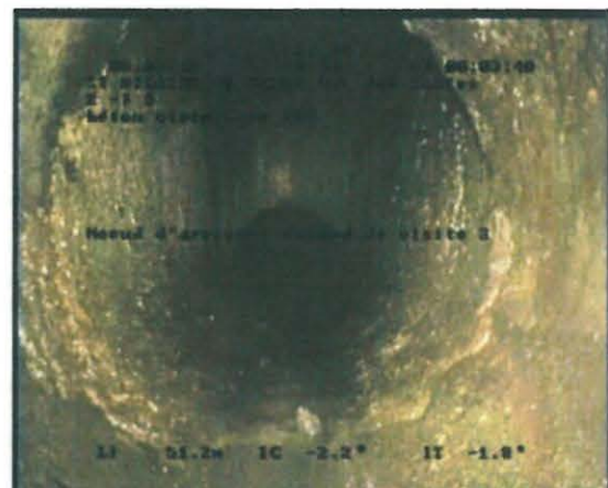
Photo: 0000014.JPG, 00:03:40 52m, Noeud d'arrivée, regard de visite 3
