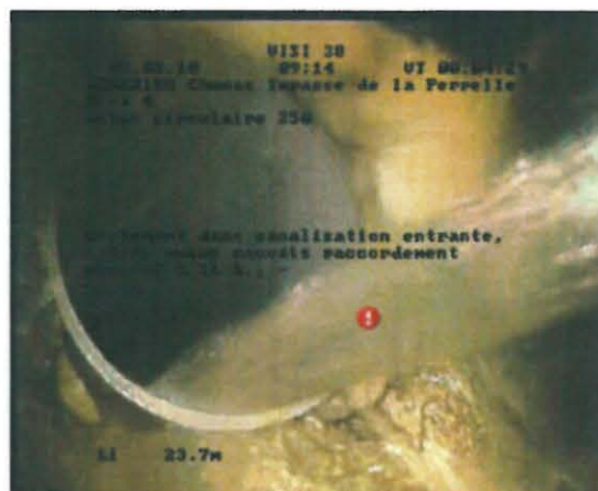
Photo: 0000029.JPG, 00:04:26 23,7m, Écoulement dans canalisation entrante, clair, aucun mauvais raccordement observé à 11 h., -
