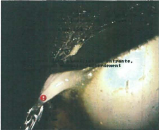
Photo: 0000015.JPG, 00:01:07 4m, Écoulement dans canalisation entrante, clair, aucun mauvais raccordement observé -, -
