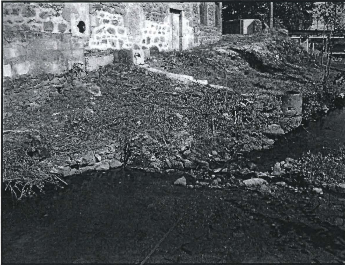
Prise d'eau en aval créée sur le rocher
