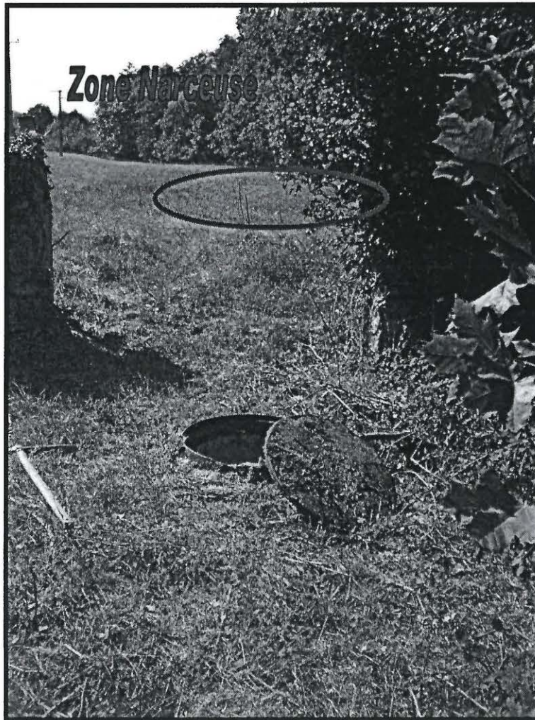
Vue intérieure du regard 3 Regard de visite 800 béton avec tampon fonte DN 650
