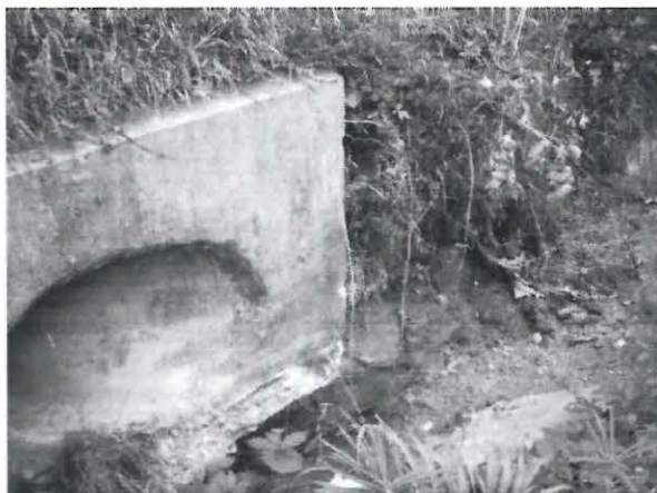
Photo 1 : Rejet déversoir d'orage
