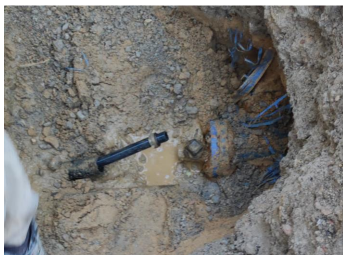
Réparation de la fuite F3
