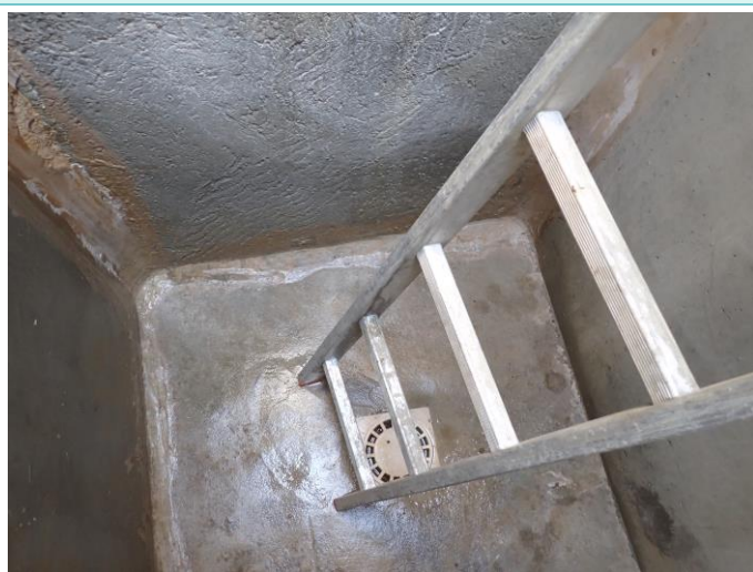
Intérieur du regard : échelle en bon état
