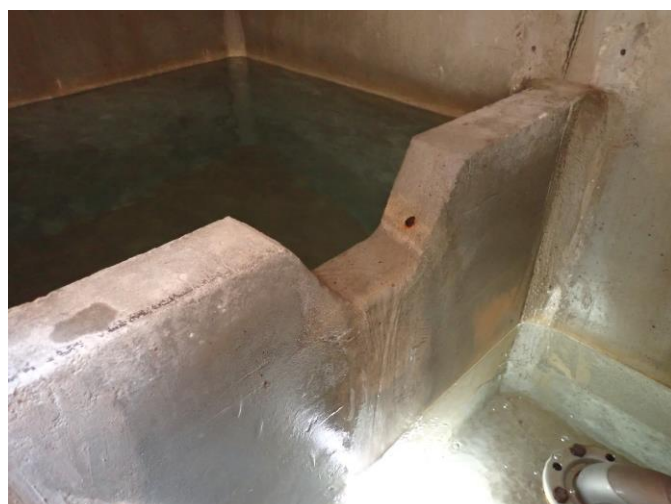
Séparation entre les deux bassins
