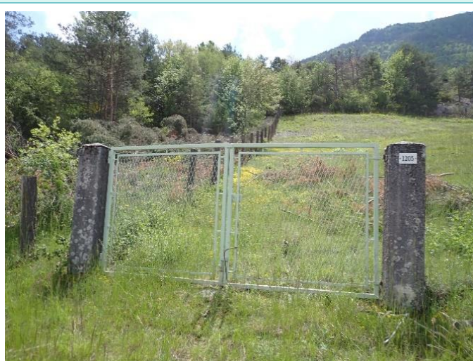
Portail d'accès au captage
