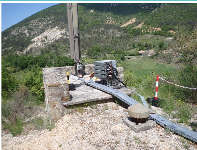
Vue de la cheminée d'aération du réservoir
