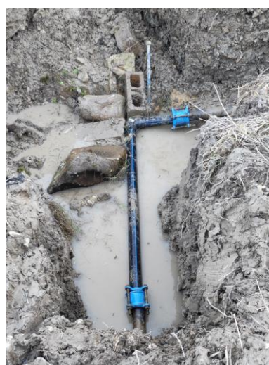
Réparation de la fuite F4
