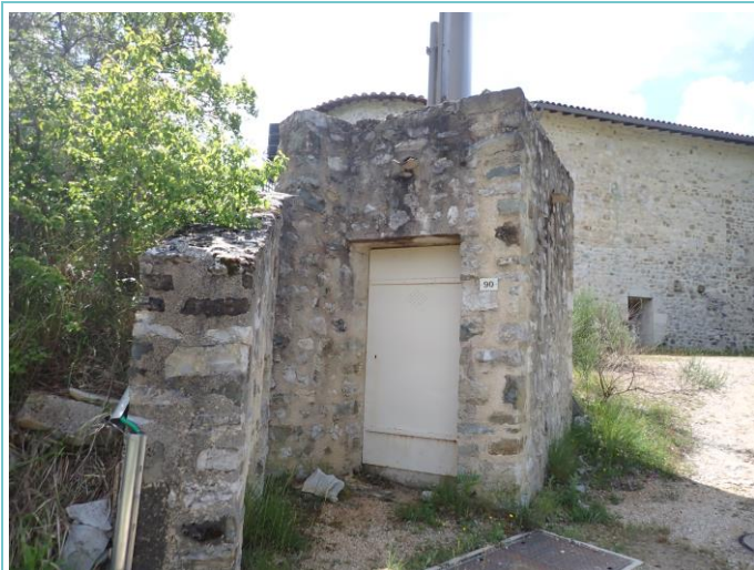
Vue extérieure du réservoir
