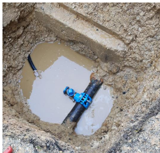
Réparation de la fuite F1
