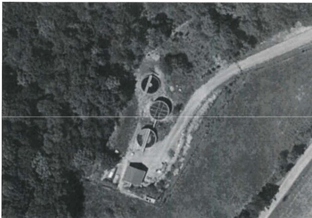
Photo aérienne de la station d'épuration de Saint Martin de la Cluze
