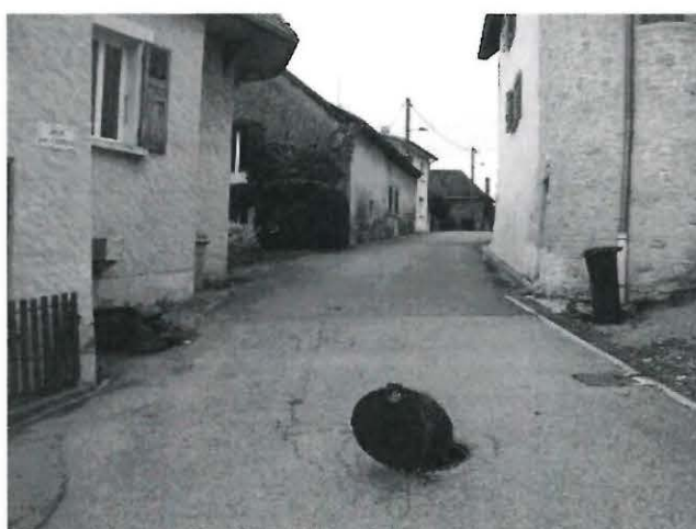
Reconnaissance du réseau et mise à jour des plans
