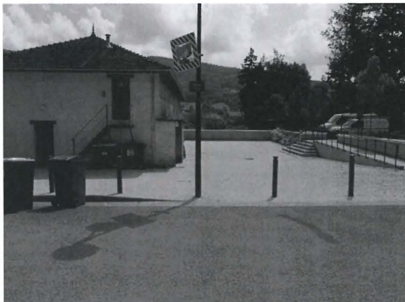
Aménagements des abords de la salle des fêtes : muret faisant obstacles / digue aux écoulements de crue
