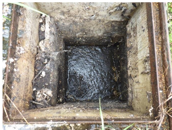
Mise en charge du réseau – Rue de la vie Folle – ID 151
