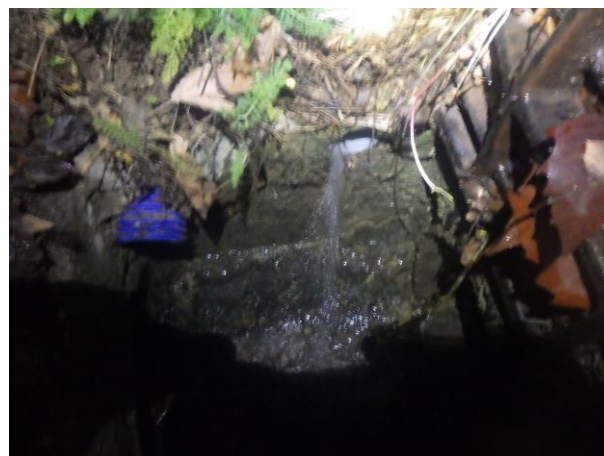
Regard n°755 – Route des viaducs – Canalisation en ø 60 mm – Drain
