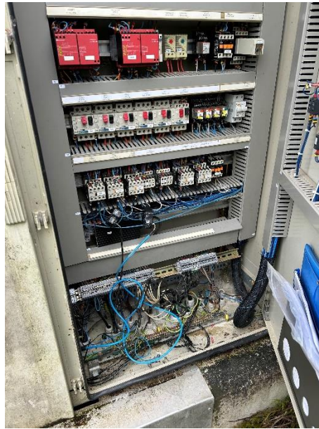
Illustration n° 14 : Point n°9 PR entrée station d'épuration
