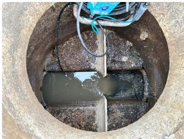
Illustration n° 13 : Point n°6 ancienne station
