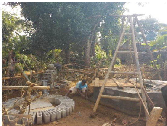
District de Farafangana – Fonçage à Tanambao (CR AMBOHIGOGO) à gauche et création du canal d'évacuation au niveau de la margelle de couverture du puits de Bekiny (CR MAHAVELO)
