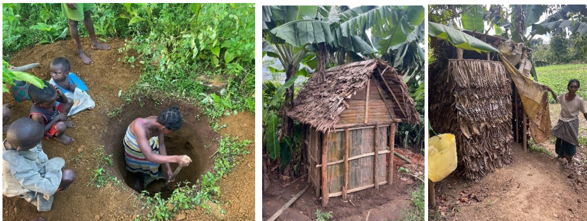
District de Farafangana, de gauche à droite : construction d'une latrine par une femme à Vodiasa (CR IVANDRIKA), latrine construite terminée à Tanambao (CR AMBOHIGOGO) et latrine présentée par une femme à Ambatosoa 1 (CR MAHAVELO)
