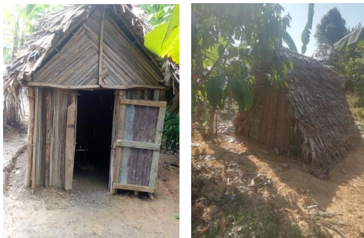
District de Manakara : nouvelles latrines construites dans les communes de Vatana (à gauche) et d'Ambahive (à droite)
