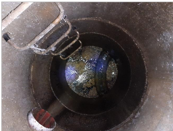
Figure 81 : Transit d'ECP dans les réseaux de Mont Brouilly
