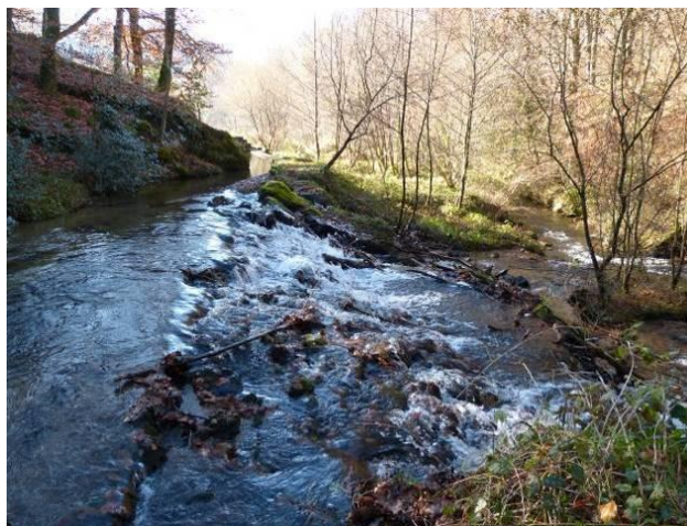
Seuil du captage AEP de Longuecoste Montet et Bouxal(Bervezou)
