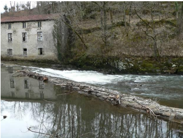
Chaussée du moulin de Baldy (Bagnac)
