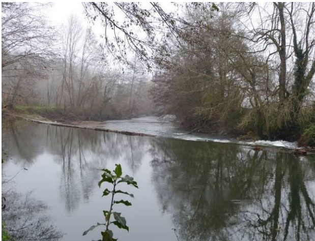
Chaussée de Merlançon (Figeac)
