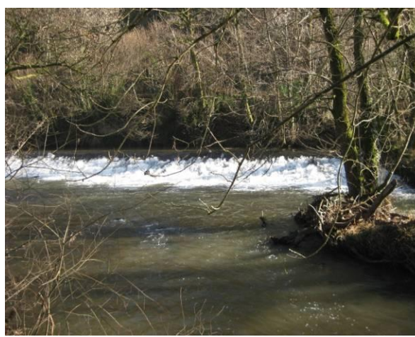
Chaussée des Brauges – Maurs (Rance)
