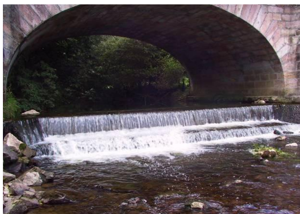
Seuil du pont de la RN 122 – Linac / Bagnac (Veyre)
