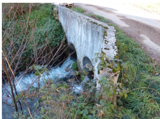
Pont busé du Moulin de Laborie (Bervezou)
