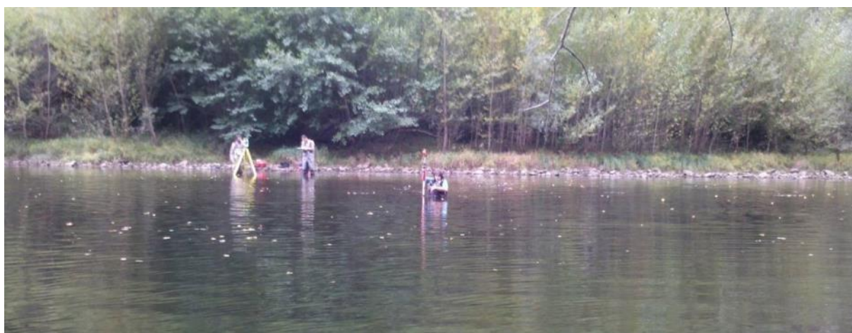
Photo 10 : Relevé topographique avec un tachéomètre
