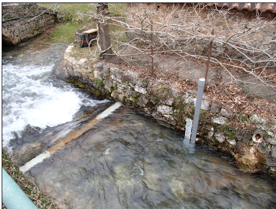
Figure 14. Seuil de mesure installé à la source de Moulin de Corp
