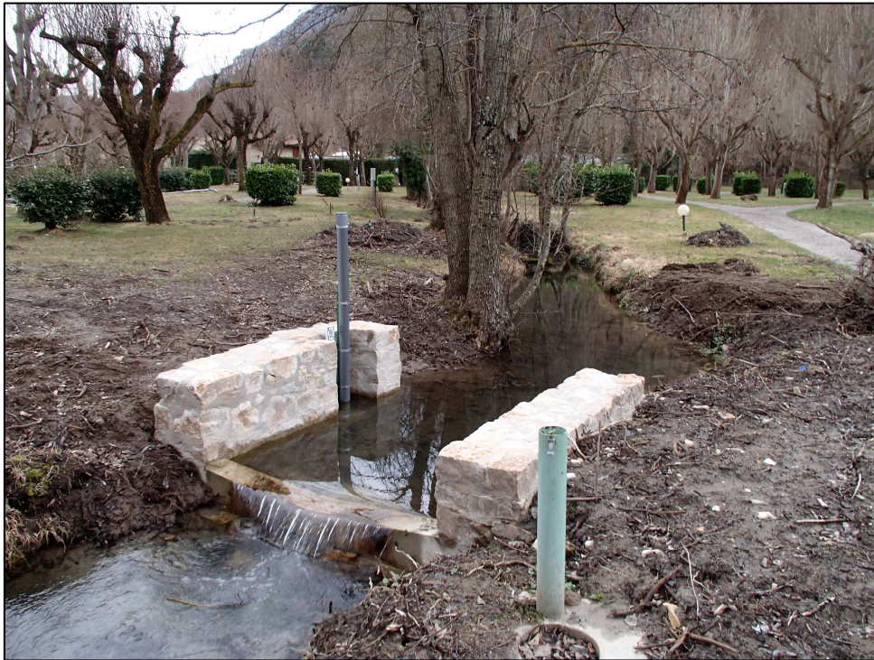
Figure 20. Seuil de mesure installé à la source de Prades
