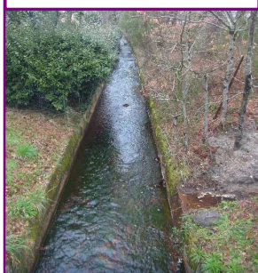
Partie bétonnée du Bétey à supprimer (Source: Safege)
