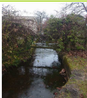
Berges bétonnées du Bétey à renaturer (Source: Safège)
