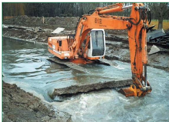
Suppression des protections de berges sur l'Orge en 1999 (Source : SIOVA)
