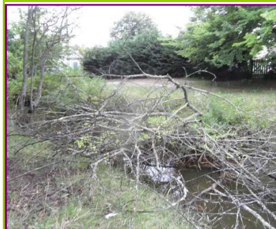
Exemple d'embâcle situé en zone urbaine sur le Bétey (Source : )
