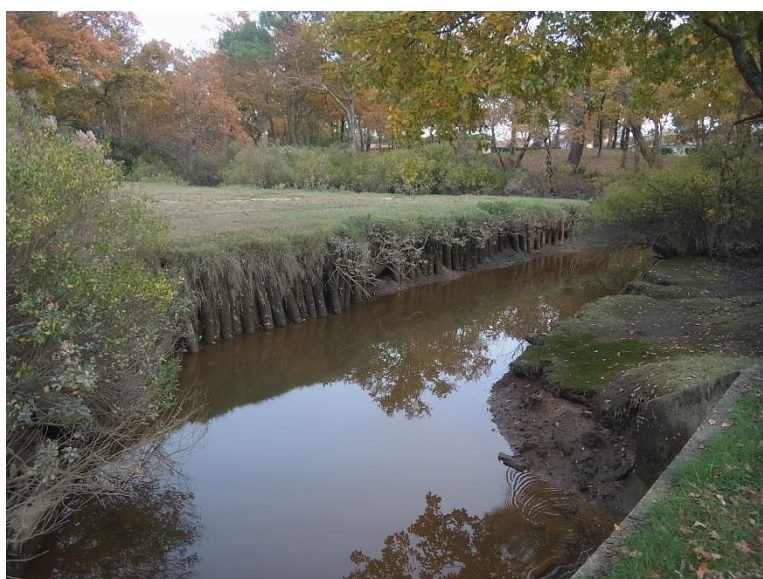
Figure 34 : Le Renêt tronçon n° 1 – tunage
