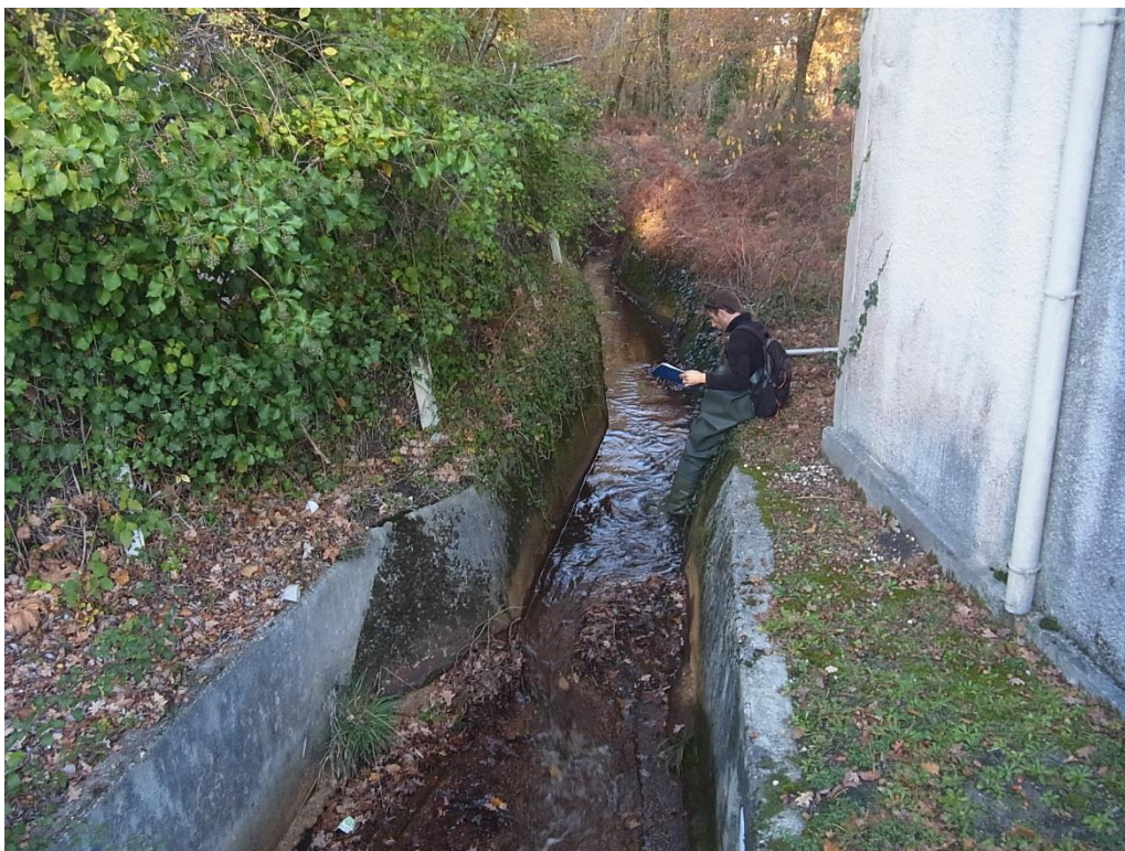
Figure 27 : Le Massurat tronçon n°4 – ouvrage
