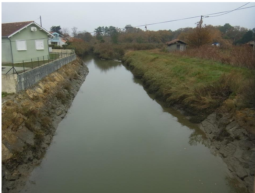
Figure 8 : Le Cassy tronçon n° 2 - aval
