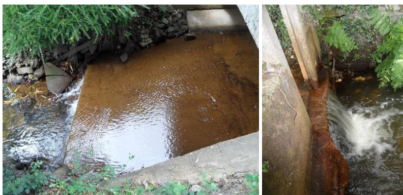
Figure 69 : Ouvrage de la RD 3 / Vestige d'ouvrage en fond de jardin
