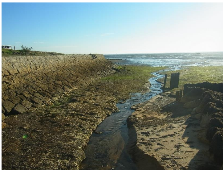
Figure 20 : Le Massurat tronçon n° 1 – exutoire
