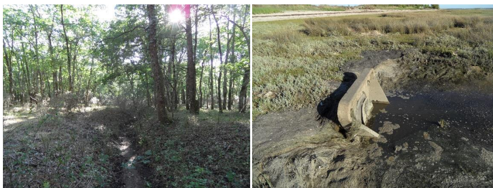
Figure 57 : Absence d'écoulement lors de l'inventaire d'août et clapet anti-retour sur l'aval
