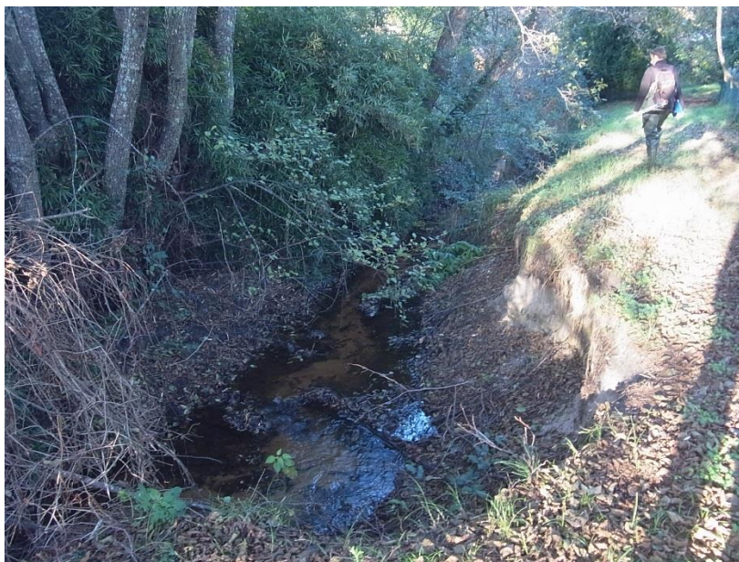
Figure 25 : Le Massurat tronçon n° 3 – érosion
