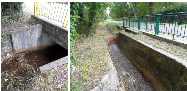
Figure 64 : Ouvrage de la RD3 / de la piste cyclable
