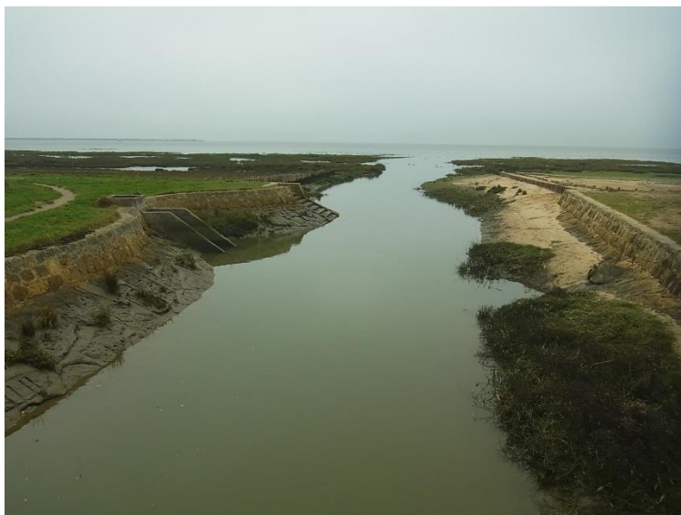
Figure 7 : Le Cassy tronçon n° 1 – vers l'aval
