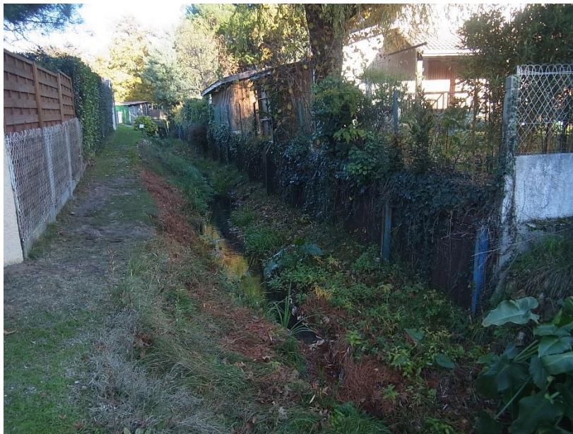
Figure 22 : Le Massurat tronçon n° 2
