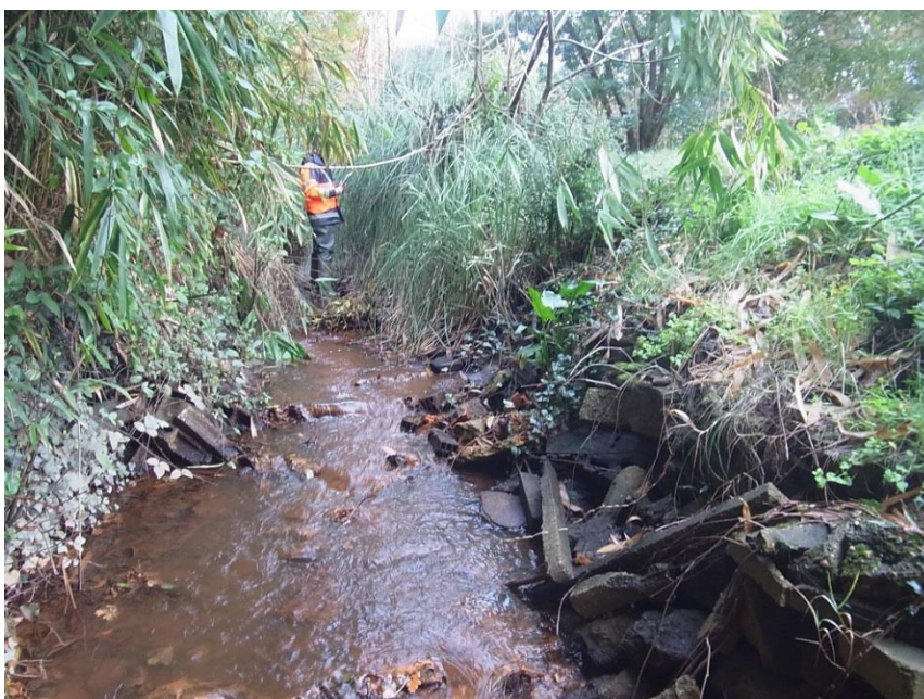
Figure 10 : Le Cassy - remblais en rive gauche et en fond de cours d'eau
