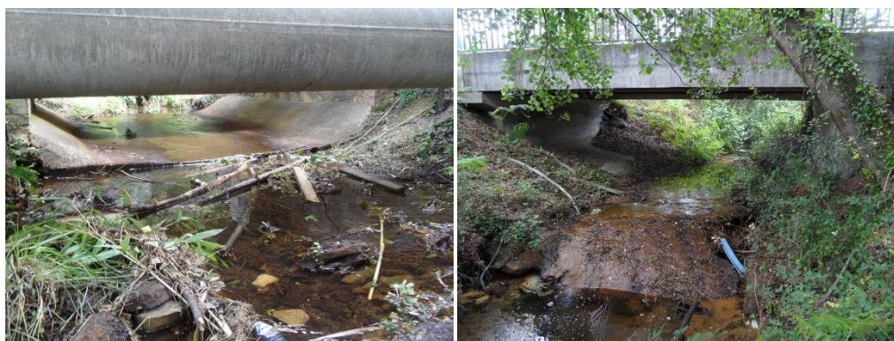
Figure 70 : Ouvrage de la piste cyclable / pont de l'allée de Titoune
