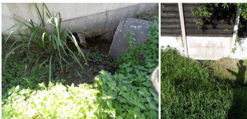
Figure 11 : Partie busée sur l'aval du linéaire
