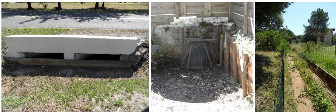
Figure 62 : Pont avec planche / Buse avec grille au camping / Cuvelage au lycée
