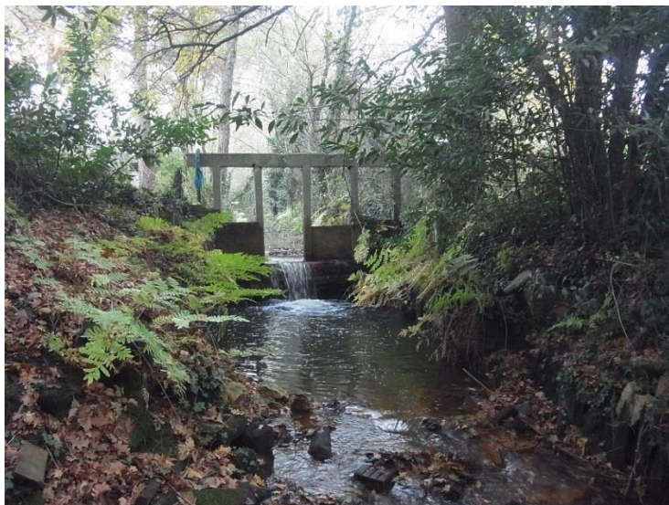
Figure 11 : Le Cassy tronçon n° 3 - ouvrage
