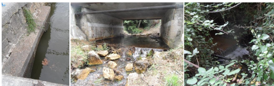
Figure 61 : Buse en sortie au niveau du port de Bétay / Seuil du radier du pont de la RD3 / Seuil du radier de l'Avenue de la source.
