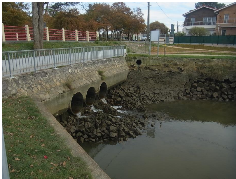
Figure 33 : Le Renêt tronçon 1 – exutoire
