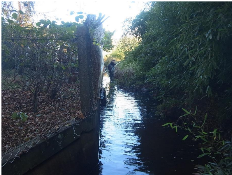
Figure 24 : Le Massurat tronçon n°2 - amont
