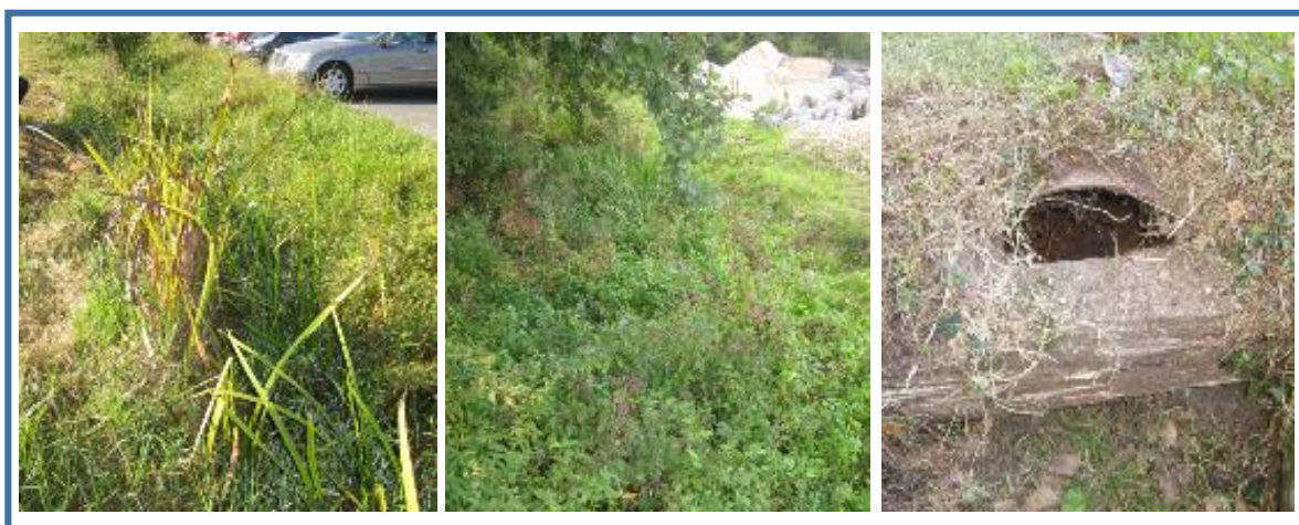
Figure 6-6 : Exemple de fossés observés
