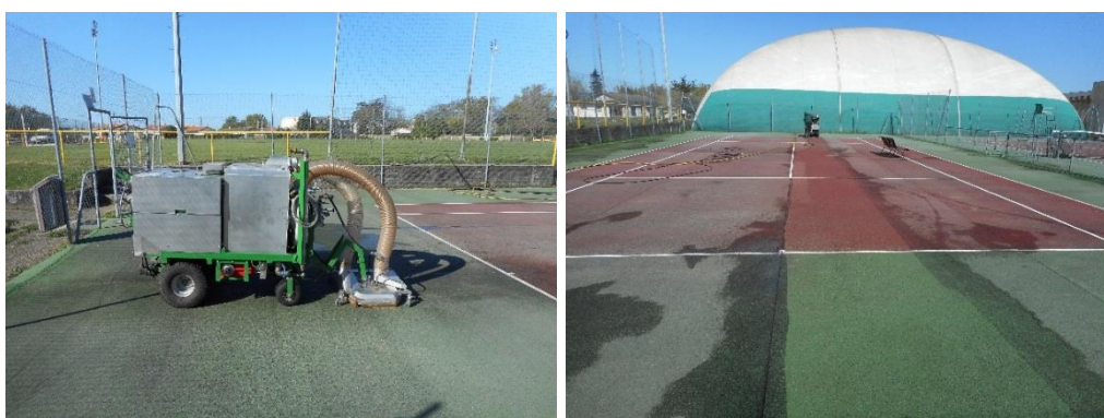
Figure 2 : Démoussage d'un terrain de tennis à l'aide d'une machine propulsant de l'eau sous haute-pression et ré-aspirant l'eau souillée.
