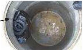
3) **Mise en place d'une lame déversante et d'un capteur piezo à l'aval**
