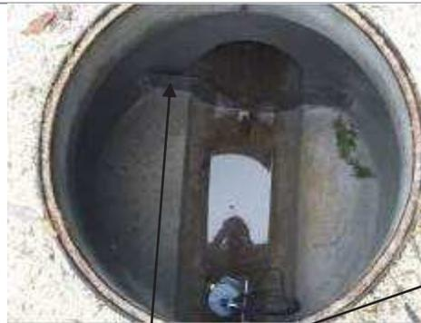
2) Réalisation d'un regard cachette pour placer le préleveur à proximité du point d'instrumentation amont
