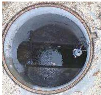
Figure 13 - Lacaussade amont : déversoir triangulaire
