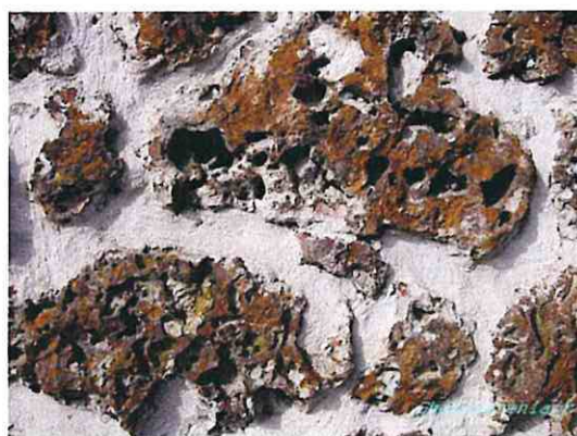
Illustration 84 : Photos de garluque (à l'état naturel à gauche et prise dans du ciment à droite)
