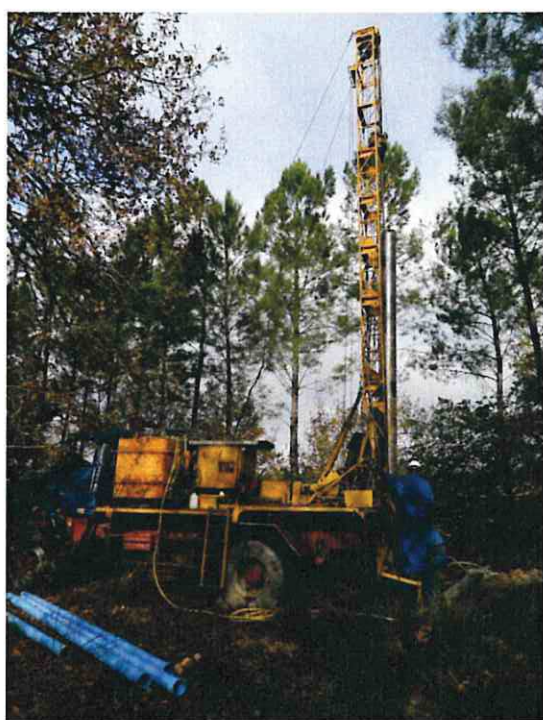
Illustration 92 : Réalisation des 3 piézomètres du 1 au 3 décembre 2014
