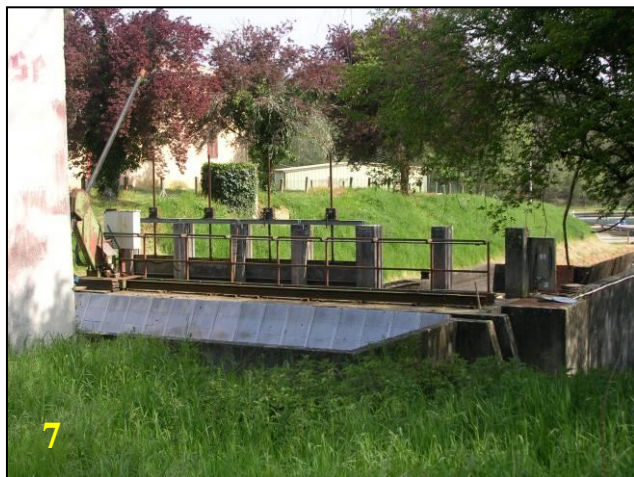
Photo 7 : Vue du dégrilleur et des vannes de prise d'eau
