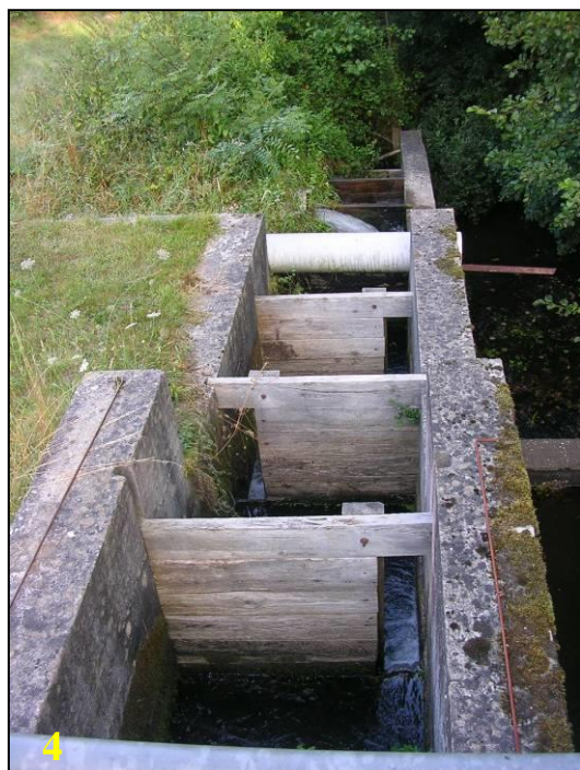
Photo 4 : Vue de la passe à poissons
