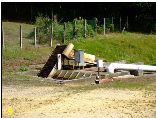
Photo 5 : Vue du dégrilleur
