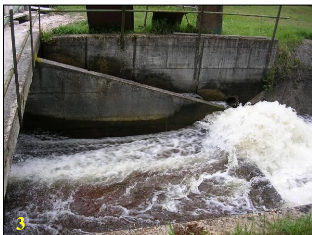
Photo 3 : Vue du radier dissipateur d'énergie
