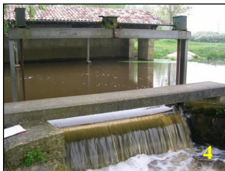
Photos 3, 4 et 5 : Vues détaillées de l'ouvrage (Déversoir gauche – vanne de décharge centrale – déversoir droite)
