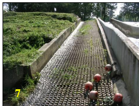
Photos 6, 7 et 8 : Vues de la passe mixte, de la passe à anguilles et du déversoir
