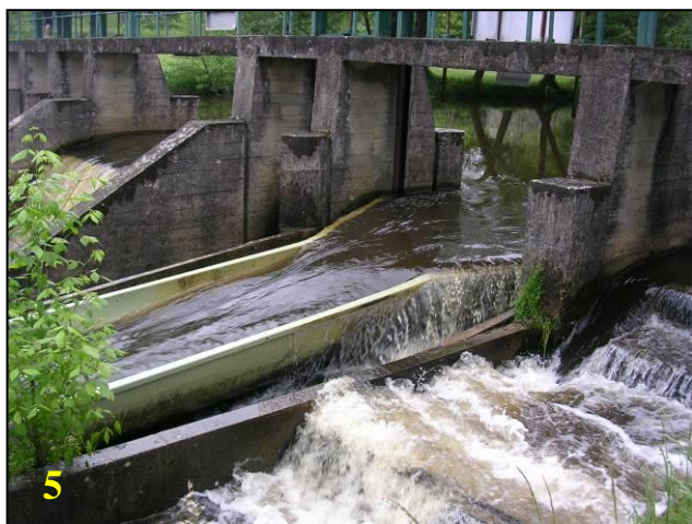
Photo 5 : Vue de la passe à canoës
