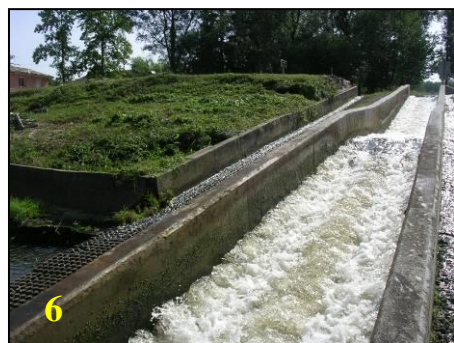
Photos 6, 7 et 8 : Vues de la passe mixte, de la passe à anguilles et du déversoir
