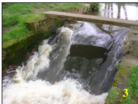
Photos 3, 4 et 5 : Vues détaillées de l'ouvrage (Déversoir gauche – vanne de décharge centrale – déversoir droite)
