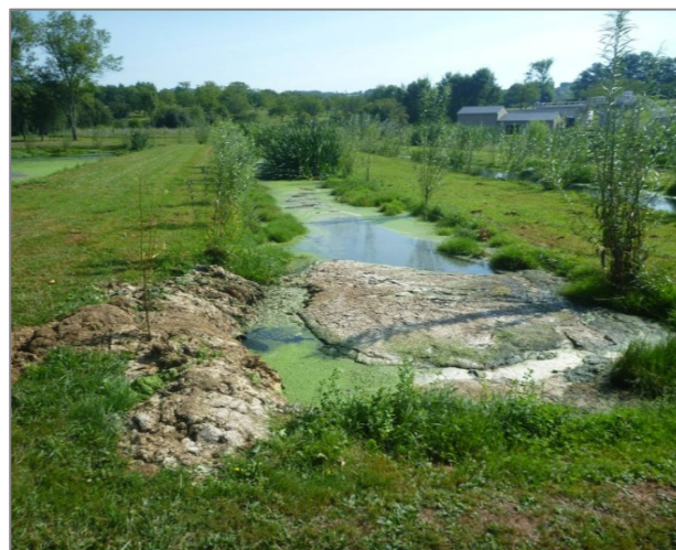
Figure 30 : Résultat d'une accumulation importante de lentilles d'eau en sortie d'un ouvrage
