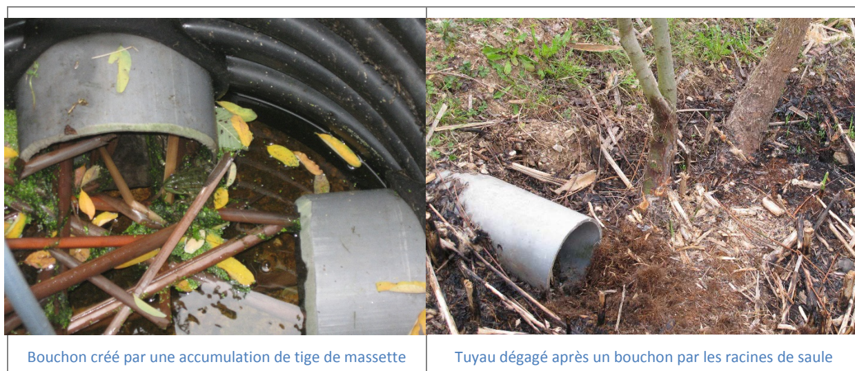
Figure 31 : Désordres hydrauliques sur les ouvrages de liaison liés à la végétation
