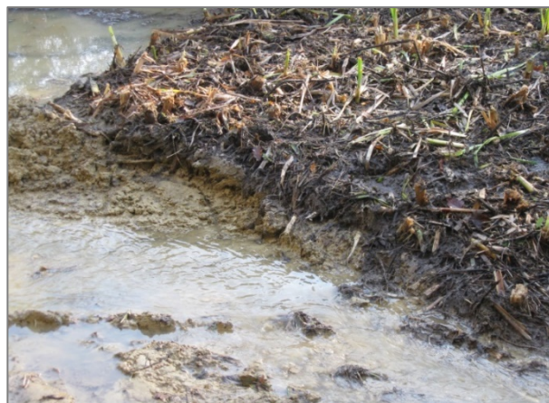
Figure 27 : Couche de dépôts dans la ZRV de Montans (photo prise lors du curage)
