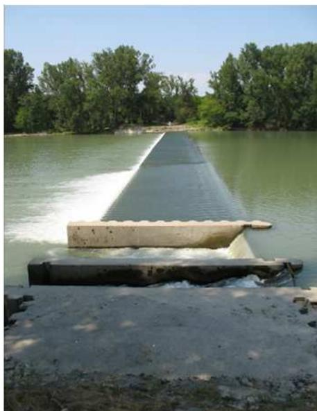
Du point de vue hydraulique l’écoulement dans chaque bief est donc indépendant des biefs amont et aval, du moins hors débits de crue. Il est contrôlé en amont par la restitution du débit réservé et le débit déversant depuis les vannes du barrage de Malause.
