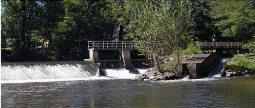
Photo 17 : Le seuil de Garavet avec passe à poissons et passe à canoës
