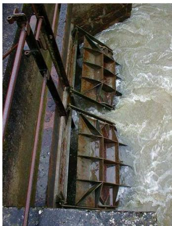
**Photographie 12 : Clapets anti-retour de l'écluse de La Poterie à Chaillevette.**
